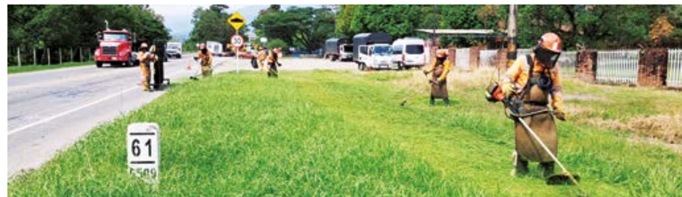
La rocería permite mantener el derecho de vía del corredor despejado para que la vegetación no oculte la señalización ni afecte la visibilidad de los conductores nocturnos.
