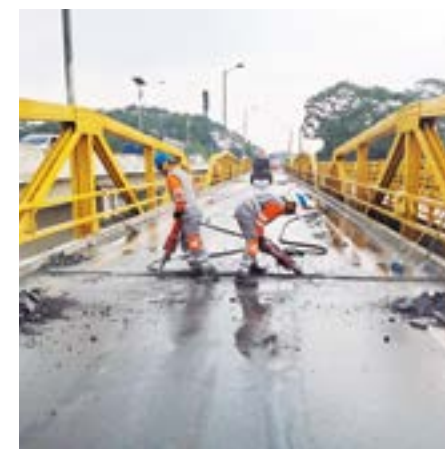
Durante este trimestre se efectuó el mantenimiento estructural de puentes como el Guamal, Carlos Lleras, San Luis de Ocoa y Caño Negro.
