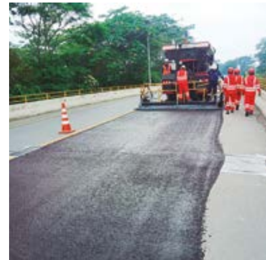
Entre Guamal y Granada se aplicó lechada asfáltica para mejorar la textura superficial del corredor.
