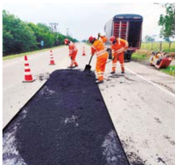
El pavimento se repara para ofrecerle seguridad a los usuarios.
