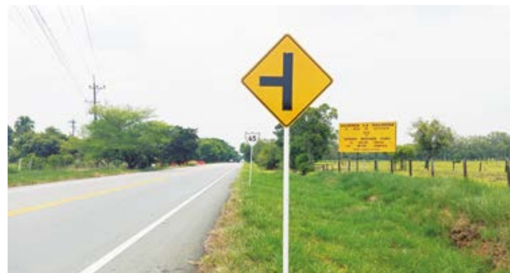
En el trimestre se repusieron 70 tableros de señales verticales que presentaban deterioro o baja reflectividad para mejorar la conducción nocturna.
