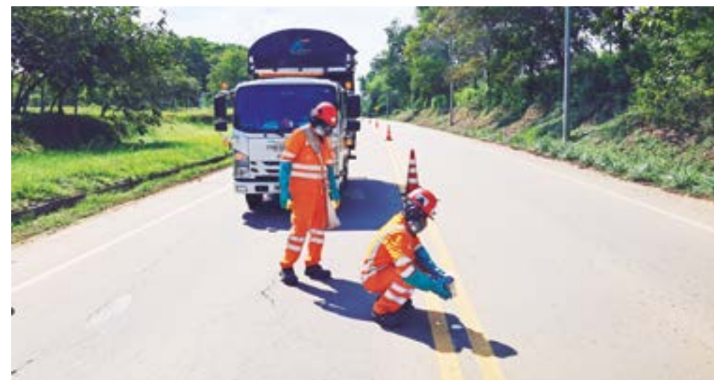
Para complementar la labor de repintado de la demarcación se instalaron más de 8.100 tachas reflectivas.
