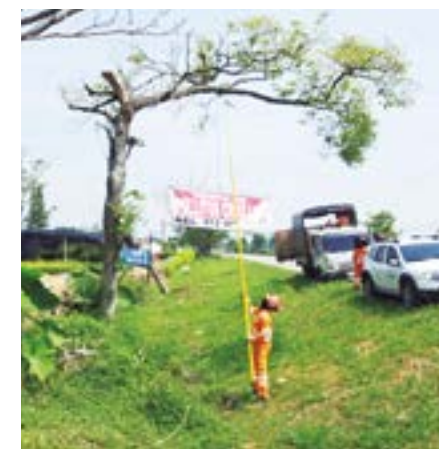
Con el fin de brindar entornos seguros para el tránsito peatonal y vehicular se efectuaron operativos de despeje del derecho de vía y retiro de materiales.
