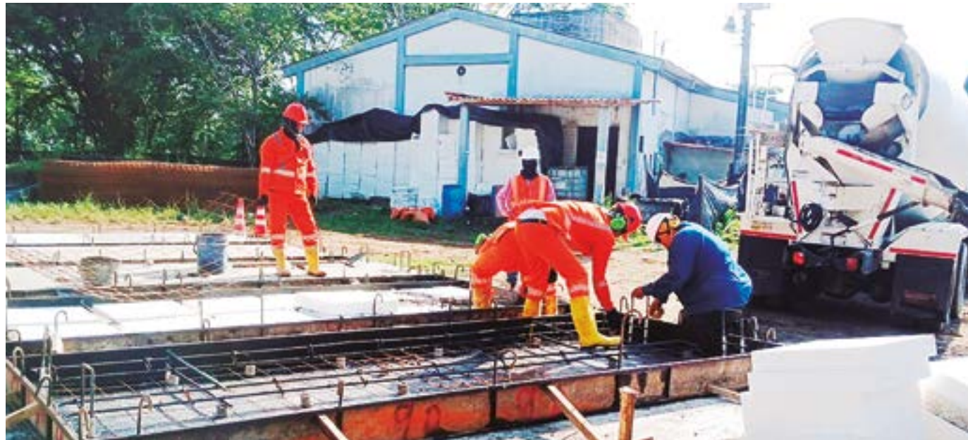
Gracias a la alcaldía de Puerto López, se facilitó el terreno de la subasta ganadera, para el armado de los geocontenedores y los gaviones, así como la fabricación de los paneles de concreto.
