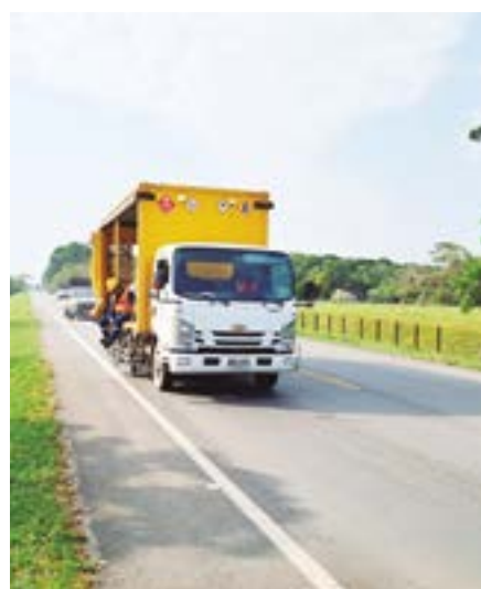
Con el repintado de la demarcación se prioriza la seguridad para los usuarios.
