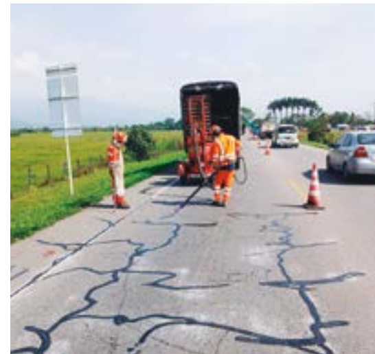
El sellado de fisuras es un trabajo que evita filtraciones de agua en el pavimento y prolonga la vida útil de este.
