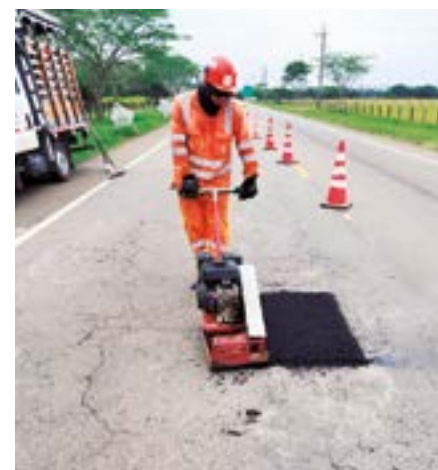
El parcheo menor de pavimento hace parte del mantenimiento rutinario que realiza el concesionario.
