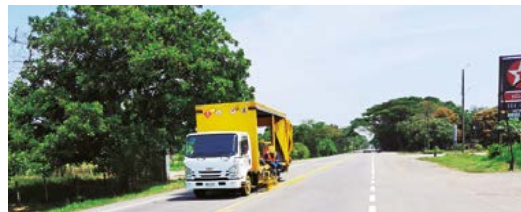
Para fortalecer la seguridad vial se repintaron las líneas blancas de borde y amarillas de eje en los tres corredores viales.
