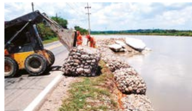
Los más de 780 gaviones que se han instalado también ayudan como medida de protección lateral y longitudinal paralela a la carretera.
