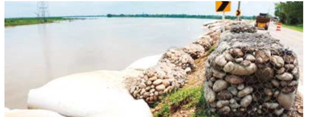
Los geocontenedores que se instalan son de material sintético de alta resistencia y cada uno tiene capacidad para 14 metros cúbicos de material de río.
