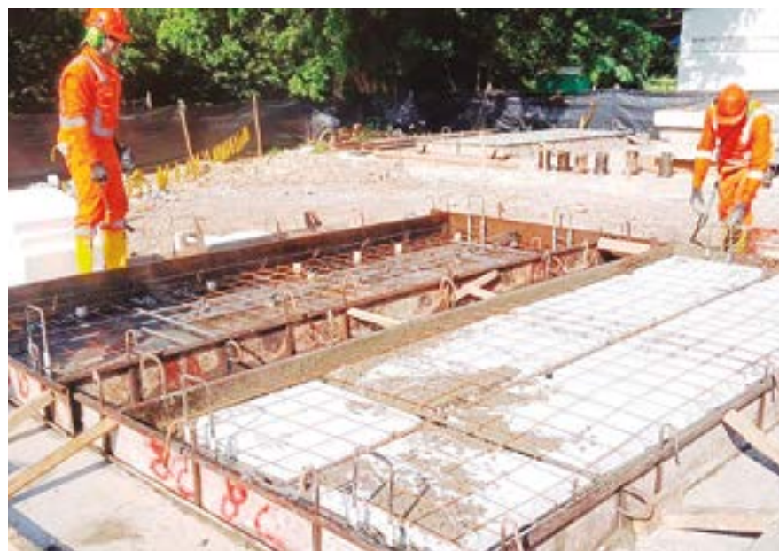
Los 138 paneles que se instalarán actuarán como barreras para disipar la fuerza de la corriente y evitar que se afecte la banca de la vía.
