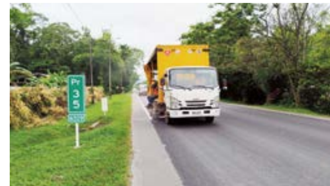
Repintado de la demarcación horizontal para ayudar en la seguridad a los usuarios de la vía.
