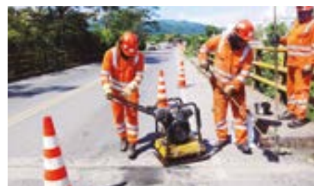
Parcheo menor de pavimento en las vías.
