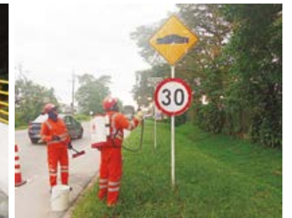
Lavado de señales verticales.
