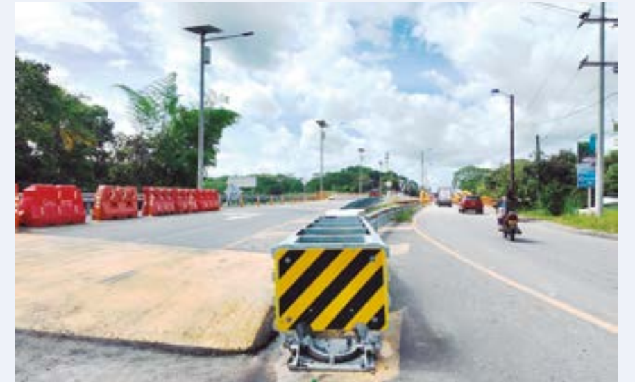
Instalación de amortiguadores en los accesos del puente Guamal.
