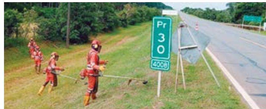
Labores de rocería en la vía Villavicencio - Granada
