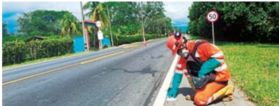
Instalación de tachas para ayudar a la seguridad vial de los usuarios, especialmente en la noche.
