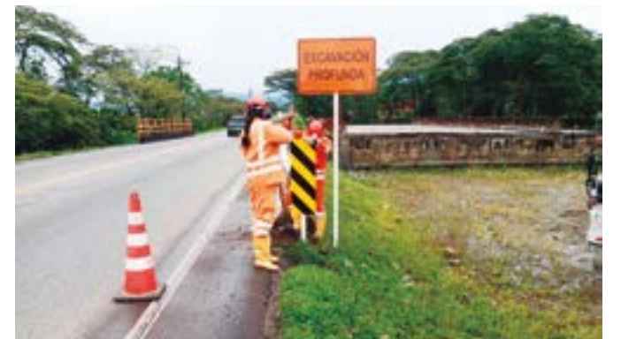
Instalación de hitos delineadores de vía, tableros y marcadores de obstáculos viales (MOV).
