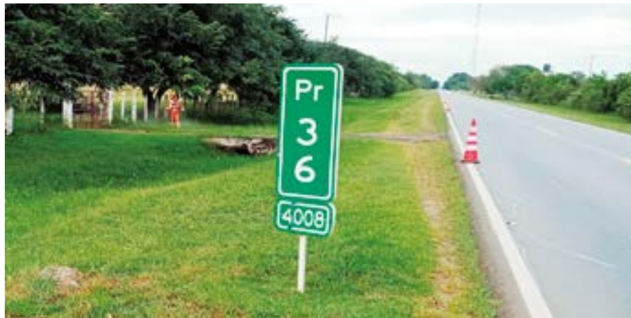
Reposición de postes de referencia o mojones en todos los corredores del Proyecto.noche.
