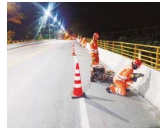
Mantenimiento de alcantarillas y puentes.
