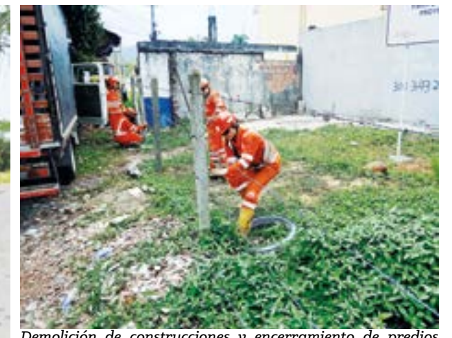
Demolición de construcciones y encerramiento de predios para obras del Proyecto.
