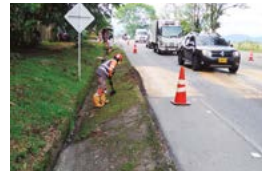
Limpieza de cunetas y alcantarillas para mejorar el comportamiento hidráulico del corredor vial.
