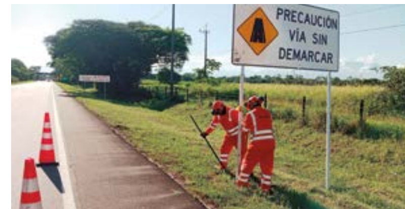
Instalación de señales verticales a lo largo de todo el Proyecto.
