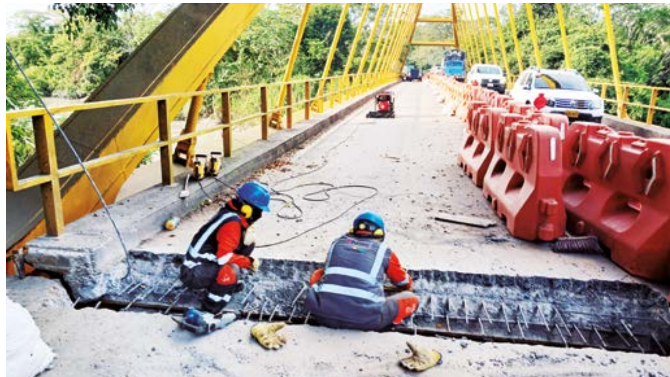
El puente La Balsa, en la vía a Puerto López, fue repintado y se repararon las juntas de expansión.
