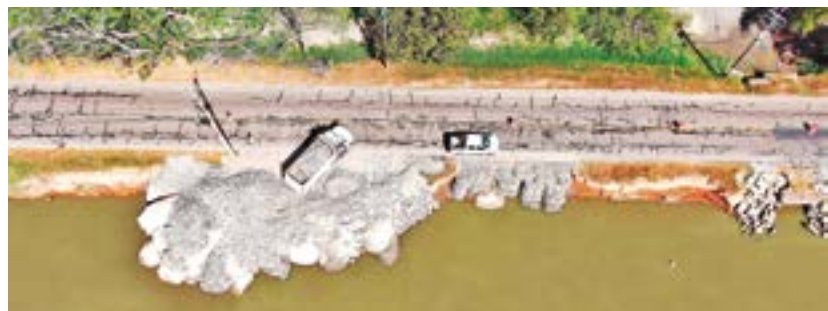
A la fecha se han puesto 1.820 m 3 de piedra grande con 644 m 3 en gaviones para reforzar los puntos estratégicos de la vía.
