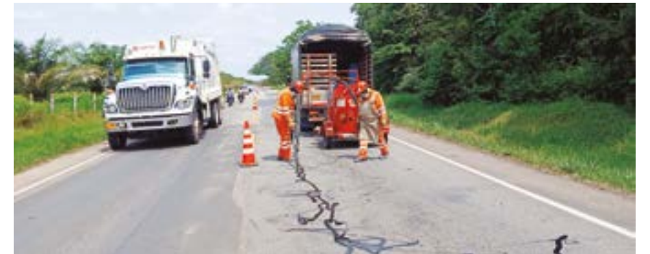
Sellos de fisuras para proteger la carpeta asfáltica.
