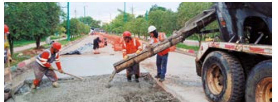
Reposición de las losas de pavimento en la vía a Puerto Gaitán.
