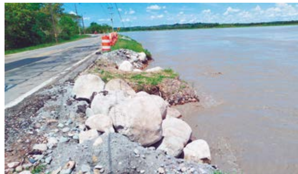
Obras de mitigación en el sector del río Metica.
