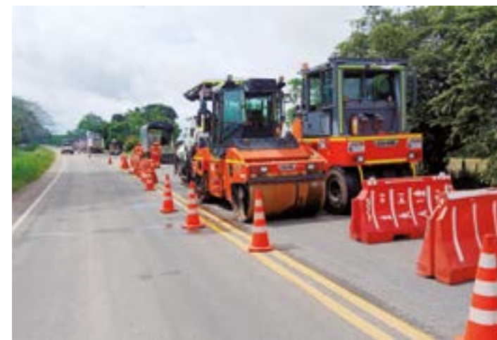
Trabajos de parcheo puntual del corredor vial.
