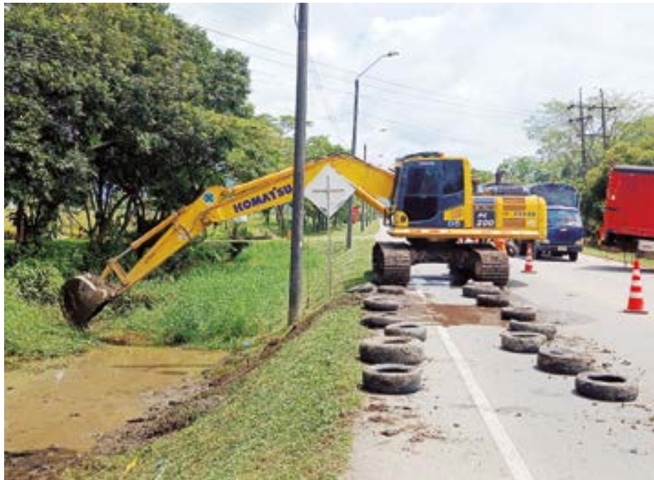
La limpieza de canales en las vías ayuda a mantener una movilidad continua para los usuarios.
