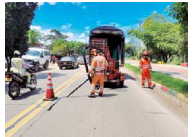
Sello de fisuras en la carpeta asfáltica.
