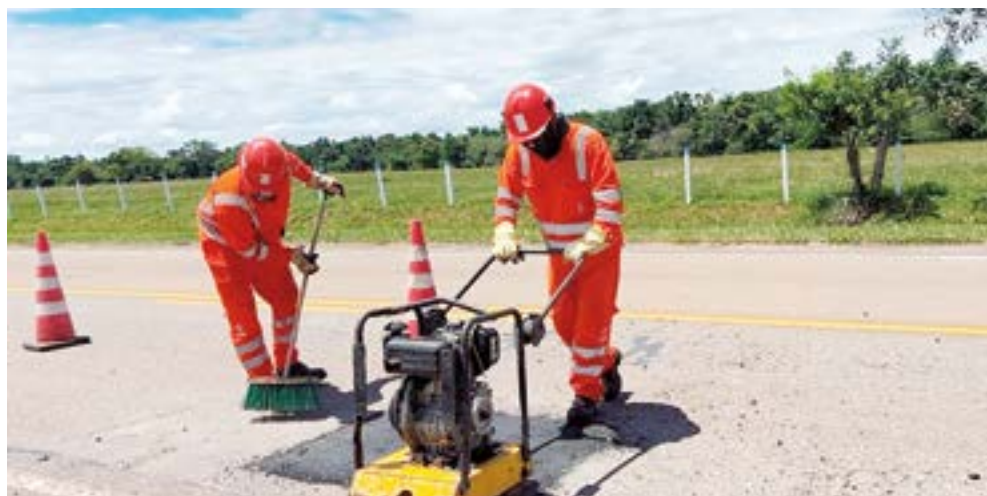
Labores de parcheo menor de la vía.
