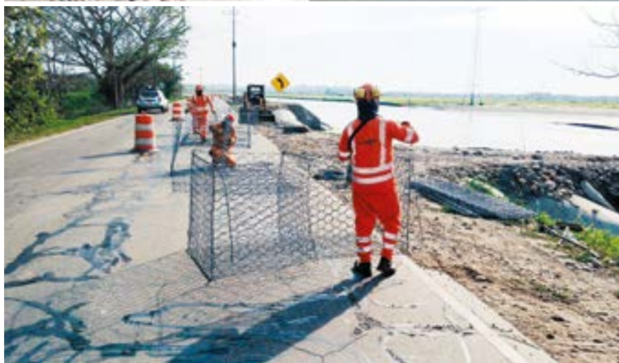
Para superar la emergencia se han instalado bolsas de concreto, material grueso y gaviones.
