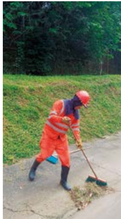
Limpieza de canales en la vía.
