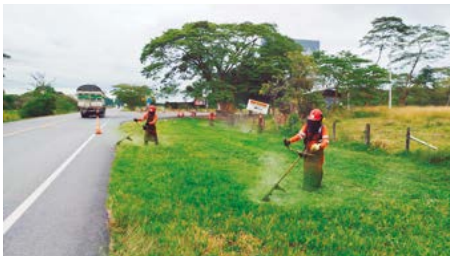
Labores de rocería en la vía Villavicencio - Granada.
