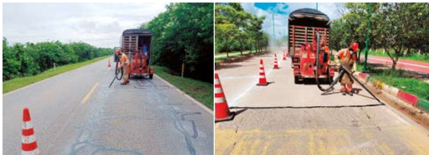
Para evitar las filtraciones de agua y prevenir el deterioro del pavimento se sellan las fisuras en la vía.
