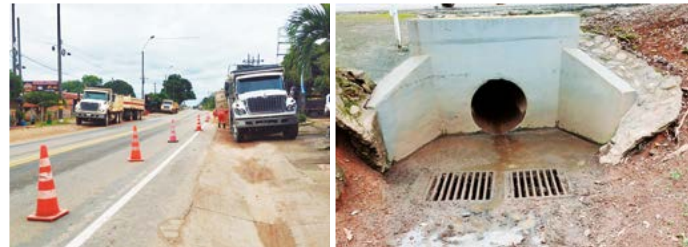
La limpieza de cunetas y de alcantarillas, especialmente en época de invierno, es importante para el mantenimiento de las vías.
