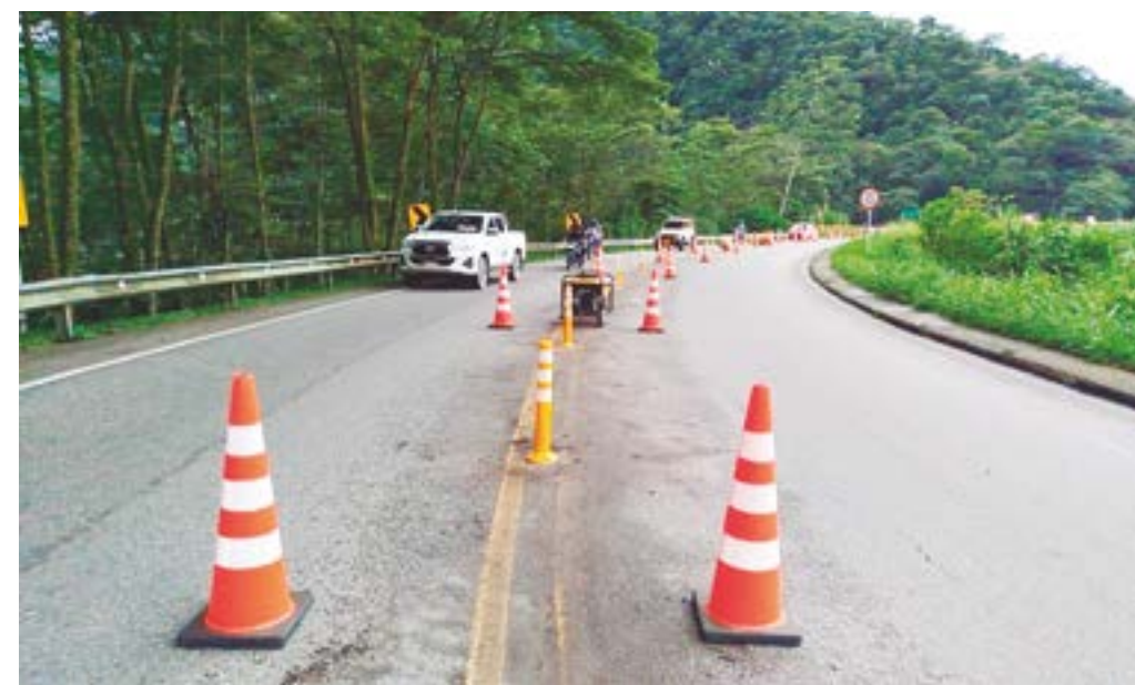
Para complementar la seguridad vial, se instalan elementos que ayudan a encausar la movilidad.
