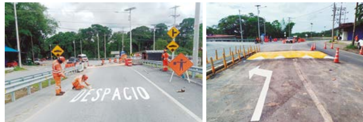
Con el fin de mejorar las condiciones de seguridad vial se repintan las marcas viales.
