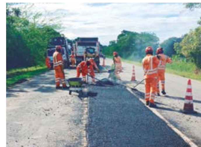
Con acciones de parcheo puntual con asfalto en caliente y en frío se mejoran las condiciones de las vías.
