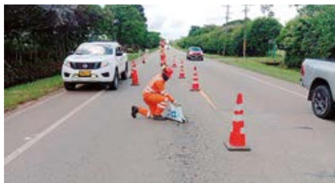
Para evitar las filtraciones de agua y prevenir el deterioro del pavimento se sellan las fisuras en la vía.
