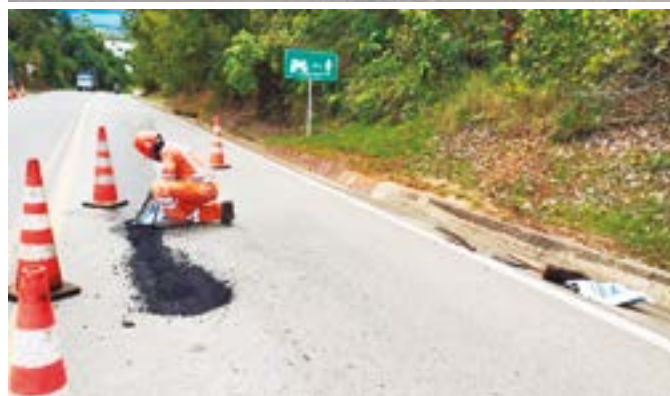
A lo largo de todo el Proyecto se reparan los baches para cumplir con los indicadores de seguridad en la vía.
