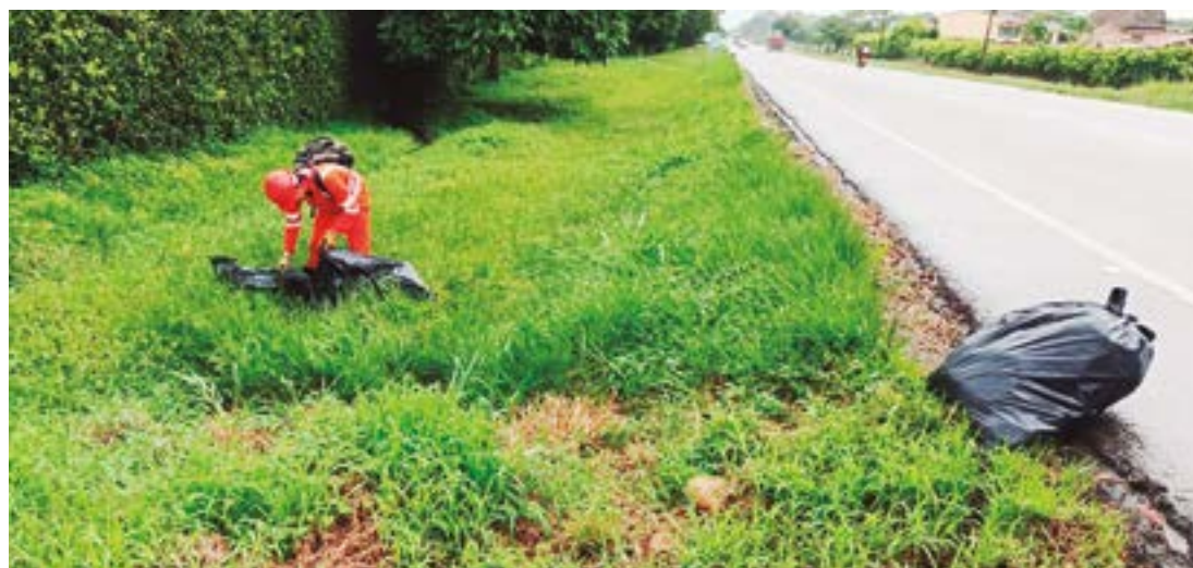
Permanentemente se realiza la rocería del derecho de vía y se recogen las basuras del espacio público de la vía.
