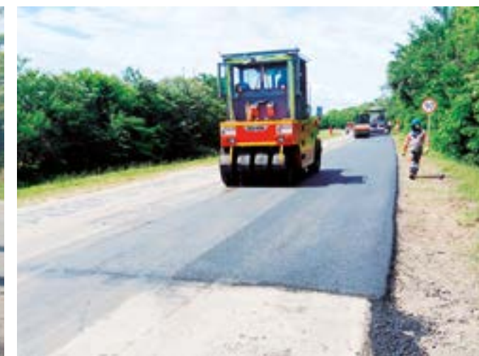
Con acciones de parcheo puntual con asfalto en caliente y en frío se mejoran las condiciones de las vías.
