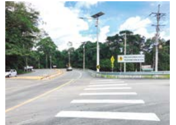
En el acceso a la vereda Montecristo, de Guamal, se realizó un complemento de defensas metálicas.
