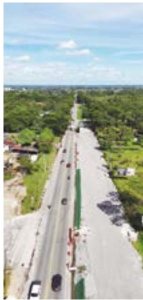
En el sector del kilómetro 22 con una reconfiguración de la vía contigua para la segunda calzada, para brindar seguridad vial.
