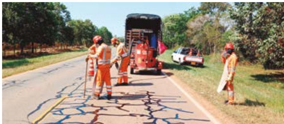
El sellado de fisuras en el pavimento hace parte de las actividades de mantenimiento rutinario a las vías del proyecto Malla Vial del Meta.
