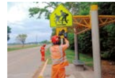
Para mejorar la seguridad de los usuarios se efectúa el mantenimiento de las señales verticales.
