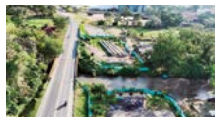
Se trabaja para finalizar la estructura del puente Colepato. Además, en el sector de La Unión, se culminó el tensionamiento de las vigas del puente.
