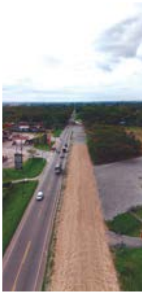
En el sector del kilómetro 22 con una reconfiguración de la vía contigua para la segunda calzada, para brindar seguridad vial.
