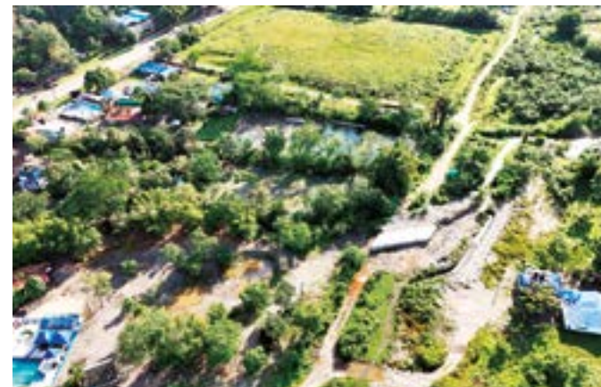
En el sector de La Cuncia se adelantan trabajando en los box culvert, estructuras de drenaje para el par vial.
