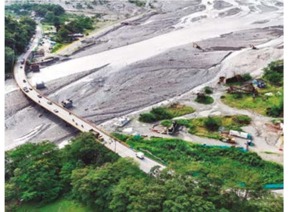
En el puente Guayuriba se avanza en lo relacionado con la infraestructura del puente a nivel de viga capital.
