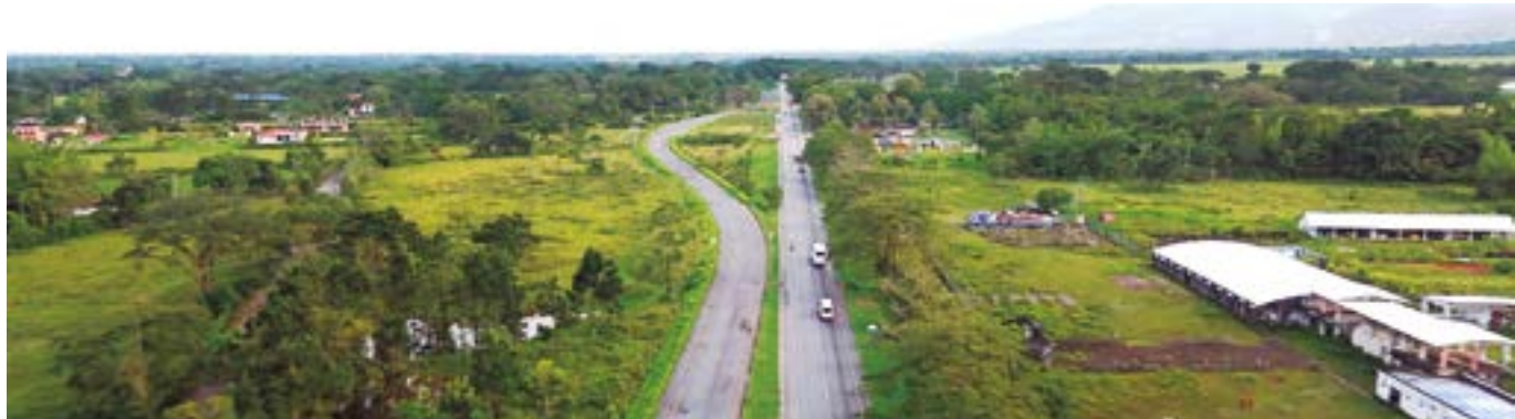
Finalizaron los trabajos en el sector del kilómetro 11, donde la zona que se tenía de conformación en separador ya quedó terminada.
