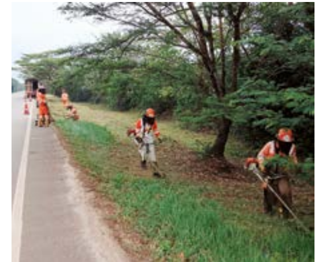
Dentro del mantenimiento rutinario está la rocería de las zonas que hacen parte del derecho de vía.
