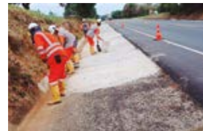
La limpieza de canales de desagüe y cunetas es importante para prevenir inundaciones en los corredores viales.
