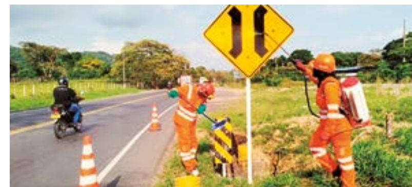
Lavado de señales verticales en la vía Villavicencio - Granada.
