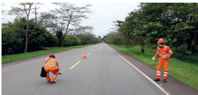
Para reforzar la señalización nocturna y mejorar la percepción de la vía se instalaron 2.453 tachas reflectivas.
