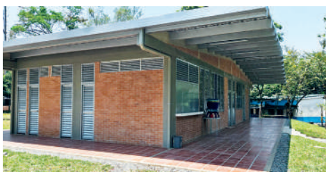
Se repuso una batería de baños, un aula múltiple, una zona de cafetería y una oficina administrativa en la I E Simón Bolívar, sede Benposta.
