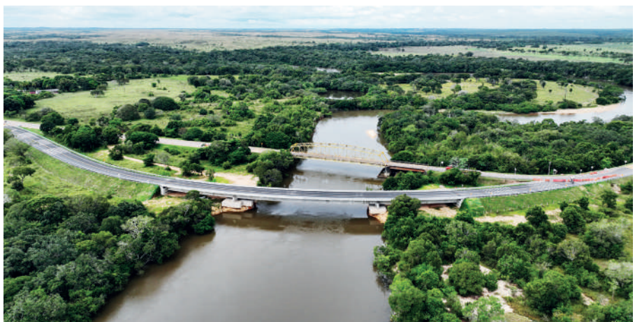
En el Puente Guamal existente se reforzó y se pintó la estructura metálica y se instaló una sobrecarpeta de concreto de ultra alta Resistencia.
