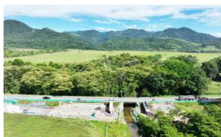
El Puente sobre caño Coburgo, es uno de los que avanzó en su construcción durante 2024.
