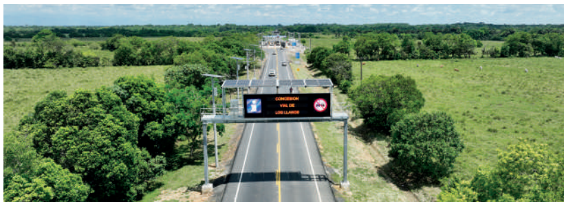
La con la instalación de paneles solares en las estaciones de peaje el concesionario implementó la autogeneración de energía renovable.
