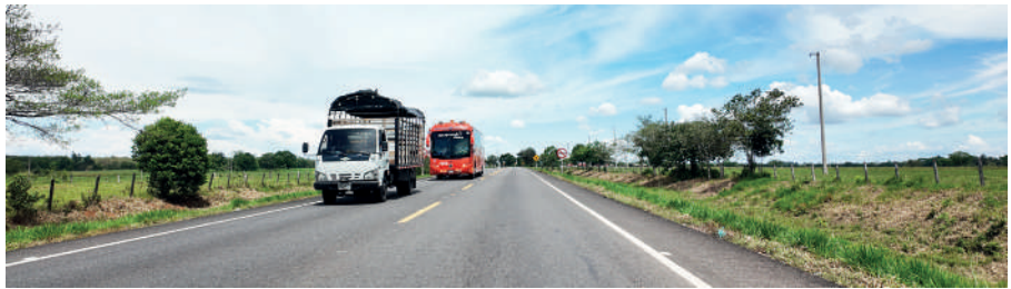
En los 40 kilómetros de la Unidad Funcional 1 se realizaron actividades de mantenimiento de la carpeta asfáltica.
