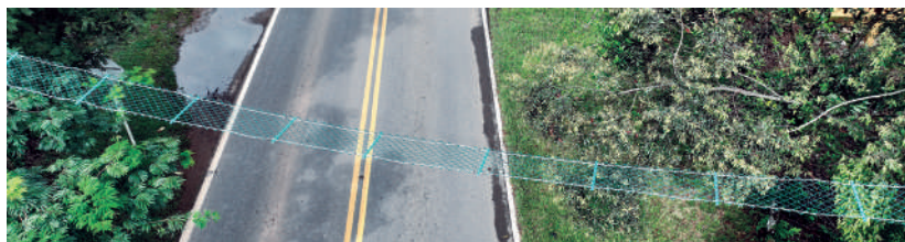
Se instalaron pasos de fauna aéreas en los corredores viales Puerto López – Puerto Gaitán y Guamal – San Martín.
