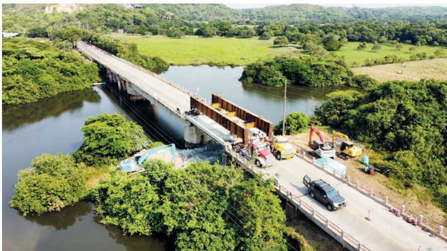
En el puente Bajo Menegua se cambiaron dos secciones en corto tiempo y utilizando una técnica innovadora.
