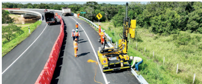
Mejorar la señalización y reforzar las barreras de protección en puentes ofrece mayor seguridad a los usuarios.
