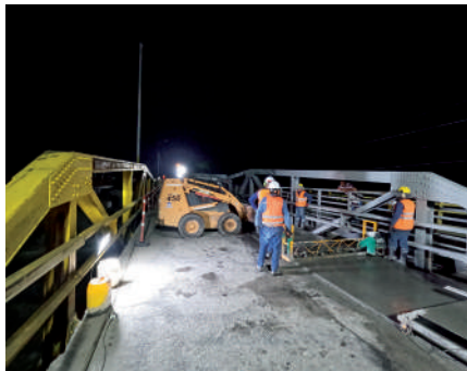
En el Puente Guamal existente se reforzó y se pintó la estructura metálica y se instaló una sobrecarpeta de concreto de ultra alta Resistencia.
