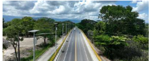
Mediante paneles solares se busca hacer uso de energías limpias para la iluminación de las estaciones de peaje y los puentes.
