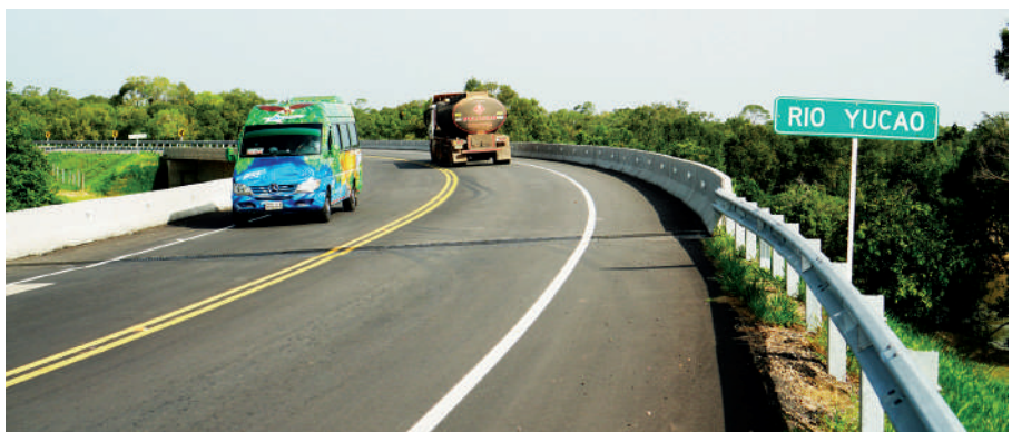
El nuevo Puente Yucao, ubicado en el kilómetro 101 de la vía Puerto López – Puerto Gitán es la obra más importante de la UF 7-8.
