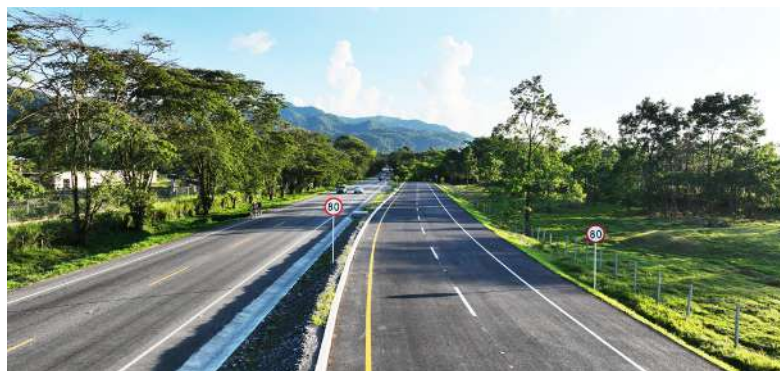
En las obras de la Segunda calzada Villavicencio – Acacías durante el 2024 se alcanzaron a culminar cerca de dos kilómetros en diferentes tramos.
