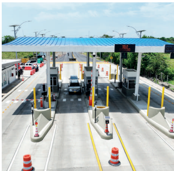
La estación de peaje de Iracá fue remodelada y ampliada al pasar de dos a cuatro carriles.
