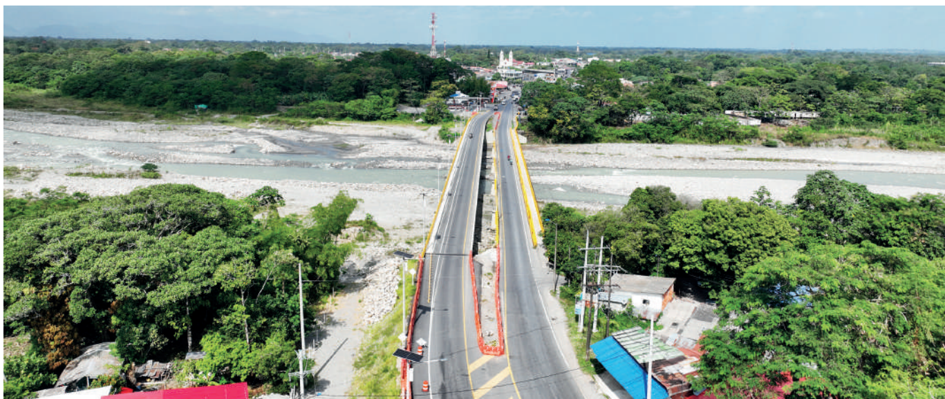
Panorámica del nuevo Puente sobre el río Guamal al lado del Puente existente, el cual fue repotenciado.
