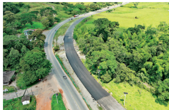
El Puente sobre caño Chupao es una de las estructuras que se culminó durante este año.
