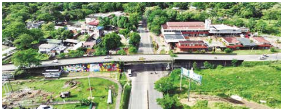
En el parque Los Fundadores, en Villavicencio, se realizan obras de traslado de redes y aprovechamiento forestal.
