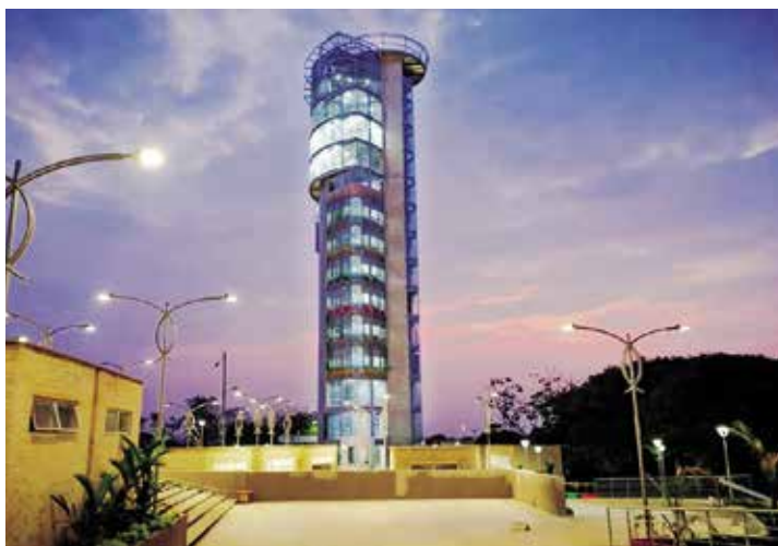
Torre mirador Matapalo en el alto Menegua, en Puerto López.
