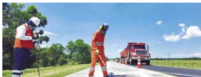
El sello de fisuras también hace parte de las labores de mantenimiento de las vías.
