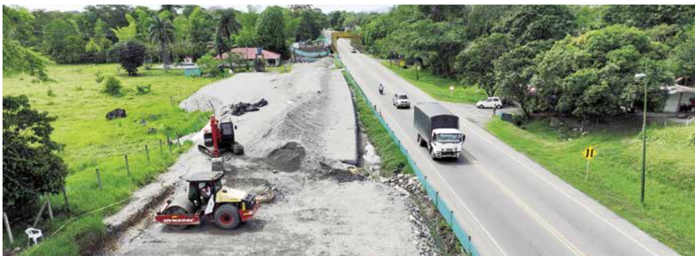
En la imagen se aprecia el avance de las obras de segunda calzada a Acacias en el sector del río Sardinata.
