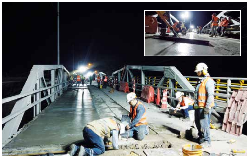
Para afectar la movilidad lo menos posible gran parte de los trabajos se realizaron en la noche.
