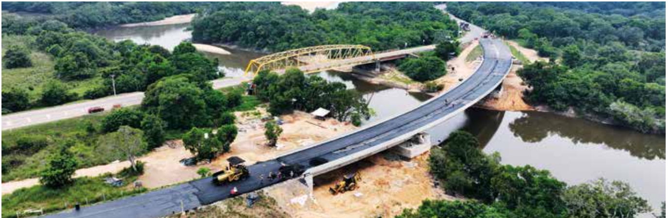
La construcción de la superestructura del nuevo puente Yucao culminó de manera exitosa.
