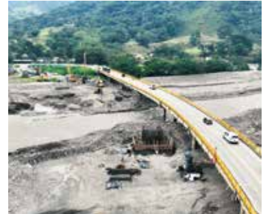
Junto al puente sobre el río Guayuríba se adelantan las obras de cimentación del nuevo puente que hace parte de la segunda calzada a Acacías.
