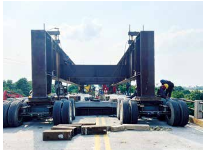
Por la magnitud de la maniobra y de los elementos utilizados fue necesario el cierre total del puente durante las dos jornadas de trabajo.
