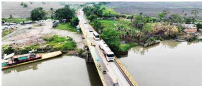
Actividades de mantenimiento del puente Carlos Lleras Restrepo en la vía Puerto López - Puerto Gaitán
