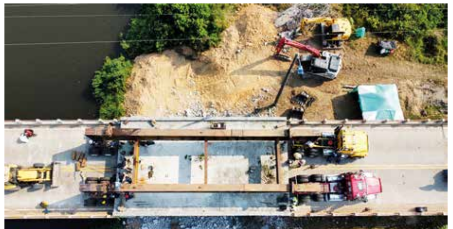
Las partes reemplazadas se transportaron con una cercha que consta de dos bigas metálicas, dos cabezotes de tractocamiones y dos juegos de llantas removibles llamadas dolly.
