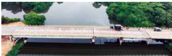
En el puente Bajo Menegua, entre Puerto López y Puerto Gaitán también se efectúan obras de mantenimiento.
