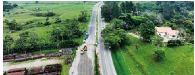
Obras de construcción de la segunda calzada a Acacías en el sector de Biomax.
