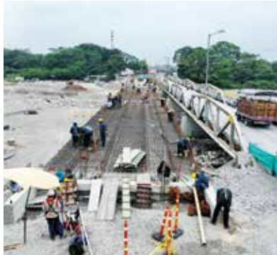
Las obras de construcción del nuevo puente Guamal avanzan con celeridad.
