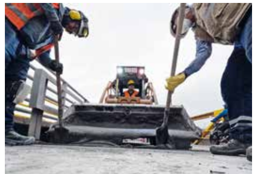
En el reforzamiento del tablero del puente Guamal existente se determinó colocar una sobre carpeta de concreto de ultra alta resistencia.
