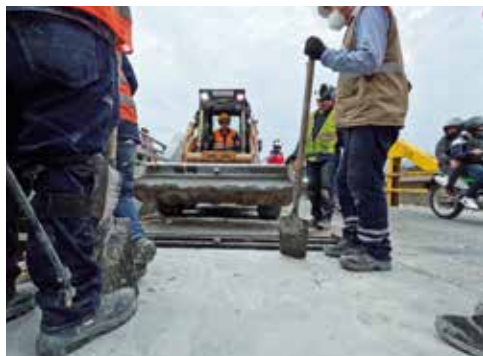
En el reforzamiento del tablero del puente Guamal existente se determinó colocar una sobre carpeta de concreto de ultra alta resistencia.
