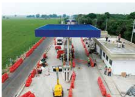
Obras de construcción del peaje Casetabla, en la vía Puerto López – Puerto Gaitán.
