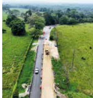
En el K 46 se realiza el empalme del mejoramiento del broche Humadea con la vía a San Martín.
