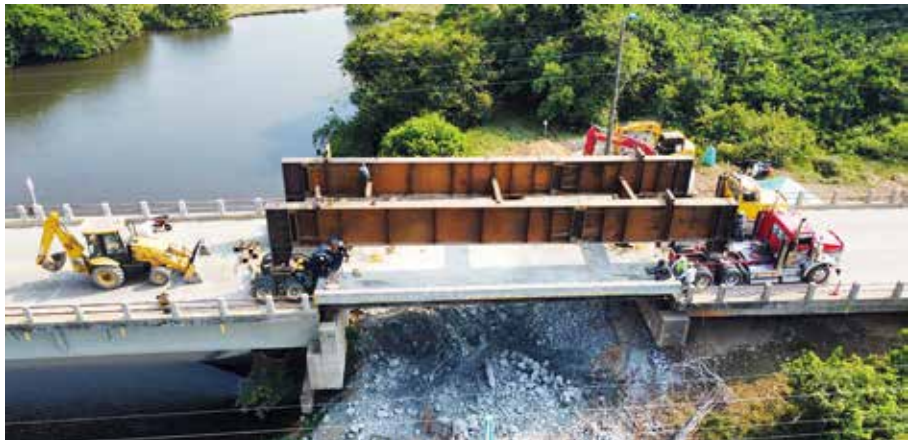
Mediante esta actividad se cambiaron las luces (secciones) 2 y 3 del puente Bajo Menegua.
