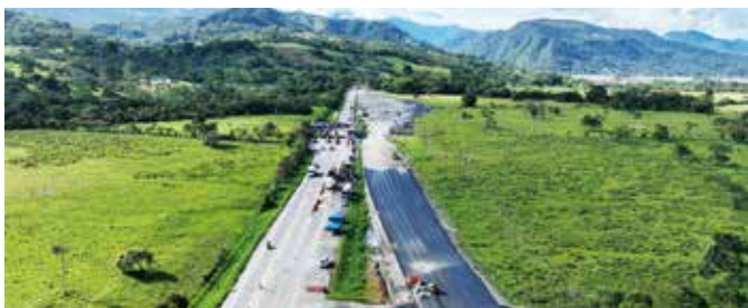
En inmediaciones del peaje Ocoa se instalaron 1.585 metros de pavimento asfáltico.
