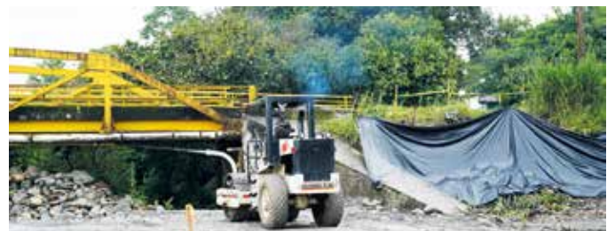
En el puente Guamal iniciaron los trabajos de alistamiento de la plataforma de cimentación.
