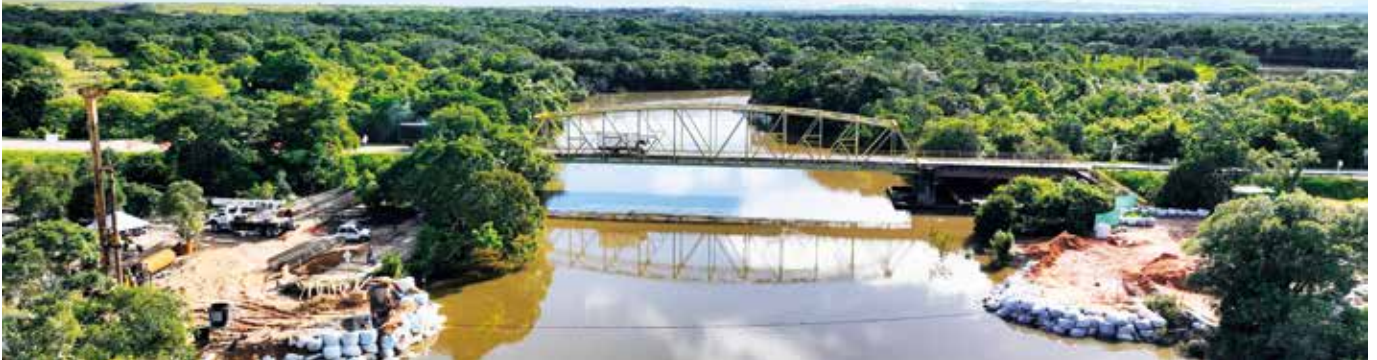
En el nuevo puente Yucao se trabaja en las obras de cimentación de los dos costados.
