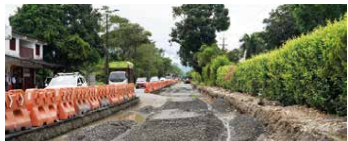
Los trabajos finales de mejoramiento de la vía en el sector de Humadea avanzan desde el puente Camelias hacia Guamal.
