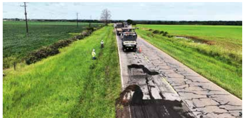
La reparación puntual de pavimento desde Puerto Gaitán hacia Puerto López se extenderá hasta agosto.
