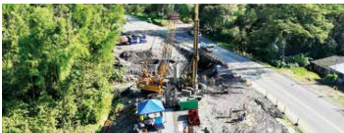
Los trabajos de cimentación del puente sobre caño Chupao, en el kilómetro 19+750, tienen un avance del 90 %.
