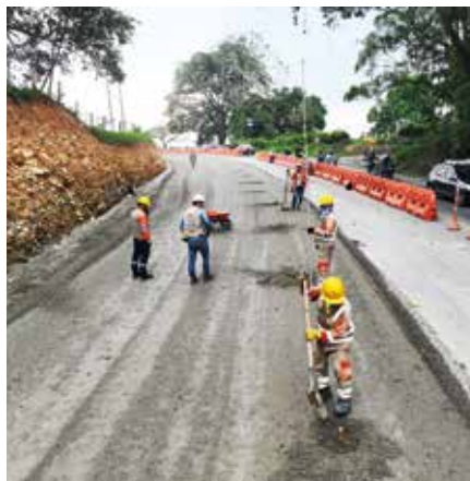
Entre Guamal y San Martín se realizan obras de mejoramiento de la vía en el sector del centro poblado de Humadea.
