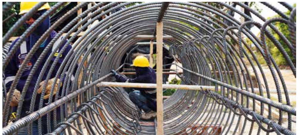
En el mismo sitio se arman las estructuras de las dos pilas que luego serán instaladas.
