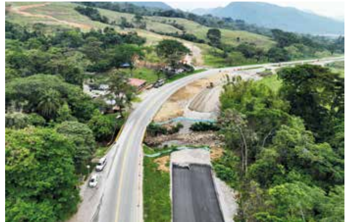
El segundo frente de obra para la construcción de la segunda calzada a Acacias va desde el kilómetro 18 hasta el 20.
