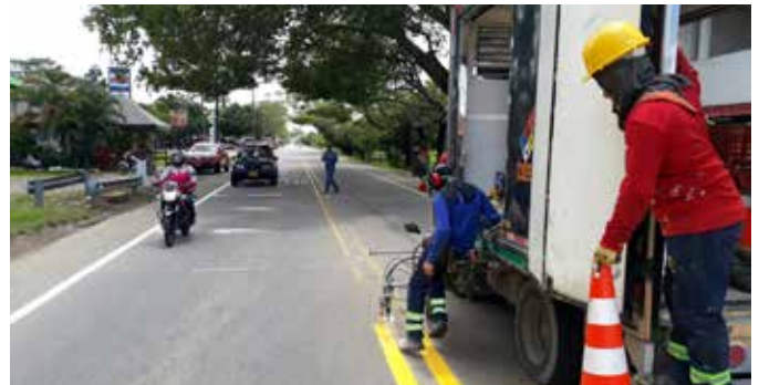
Repintado de señalización horizontal en la vía Guamal - San Martín.
