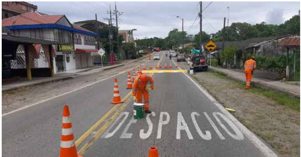
Repintado de marcas viales en el sector de Humadea, en la vía Guamal - San Martín.
