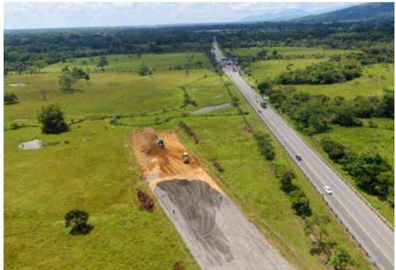
Obras en el K18 de la vía Villavicencio - Acacías, que corresponden a la construcción de la segunda calzada de este corredor vial.
