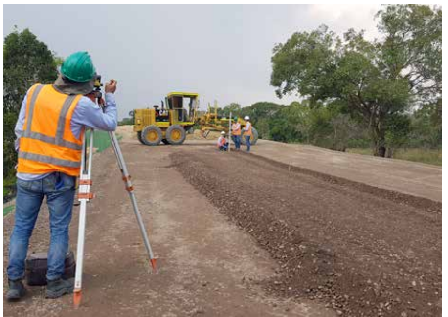
Durante este trimestre la construcción de los accesos del puente Yucao avanzaron significativamente.
