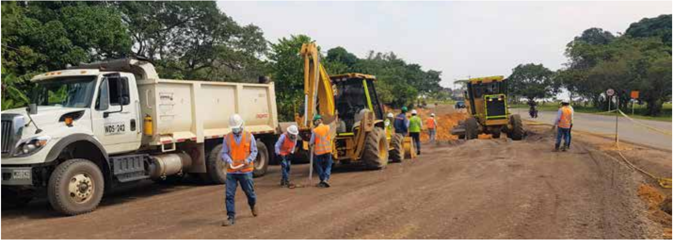
Trabajos en los accesos del nuevo puente Yucao, en la vía Puerto López - Puerto Gaitán.
