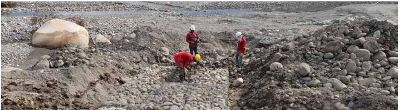
Construcción de espolón en el sector del Guayuriba para mitigar los impactos del río.
