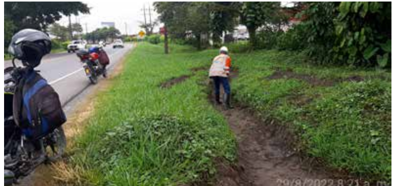
Limpieza de canales en el derecho de vía, corredor Villavicencio - Acacías.
