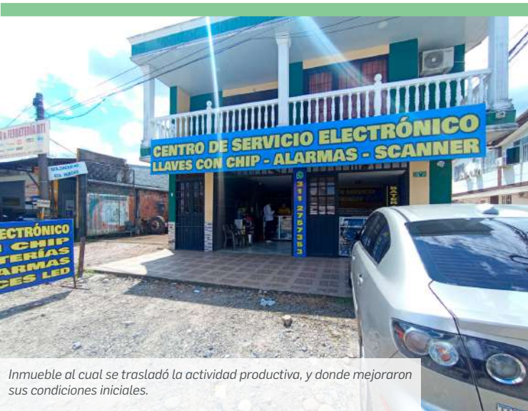
Inmueble en el cual se ubicaba la actividad productiva relacionada con la venta de accesorios de lujo para vehículos y mantenimiento eléctrico (UF2-VGN-162E); fue requerido para el desarrollo del proyecto.
