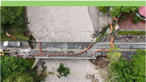
Puente Camélias. Pérdida de material en ambos costados.
