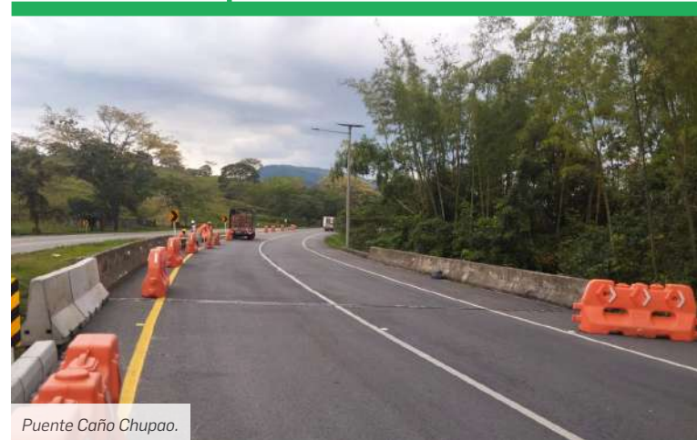
Puente Caño Chupao.
