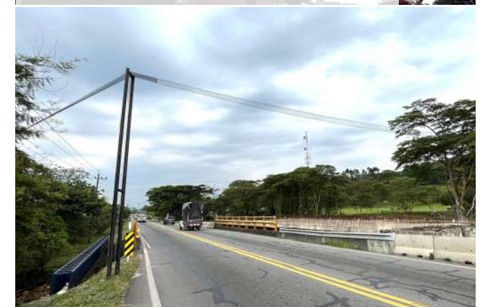
Paso de fauna aérea, caño Colepato. Tramo Ciudad Porfía-Acacías.
