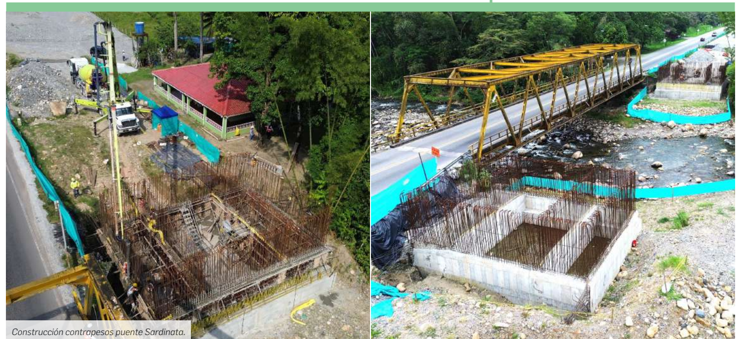
Construcción contrapesos puente Sardinata.
