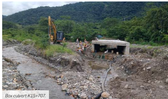
Box culvert K15+707.
