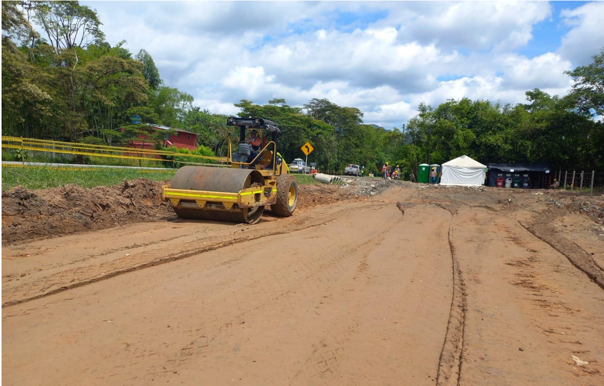
Sellado de la subrasante K10+520, Unidad Funcional 3.
