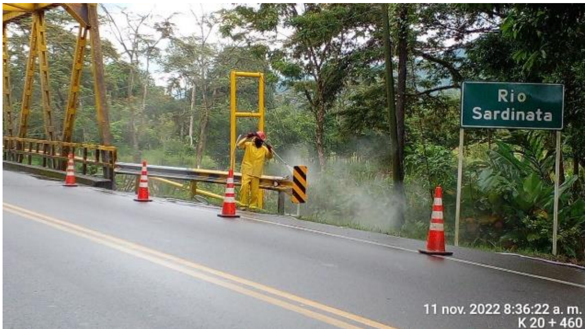
Limpieza y lavado de la infraestructura vial (señales, defensas y barandas de puentes) con las cuadrillas de mantenimiento.
