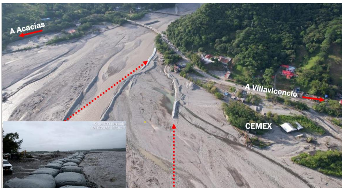
Ataguías margen izquierda del río Guayuriba, trabajan satisfactoriamente.
