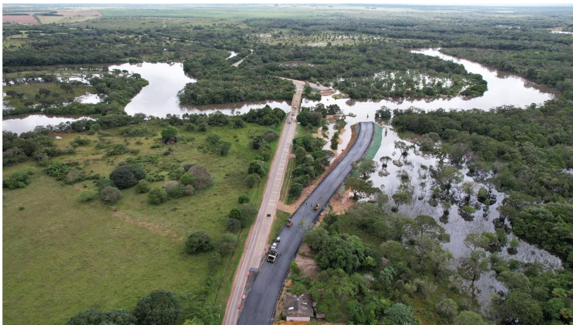
Pavimentación acceso del Puente Yucao, costado Puerto Gaitán, Unidad Funcional 7-8.
