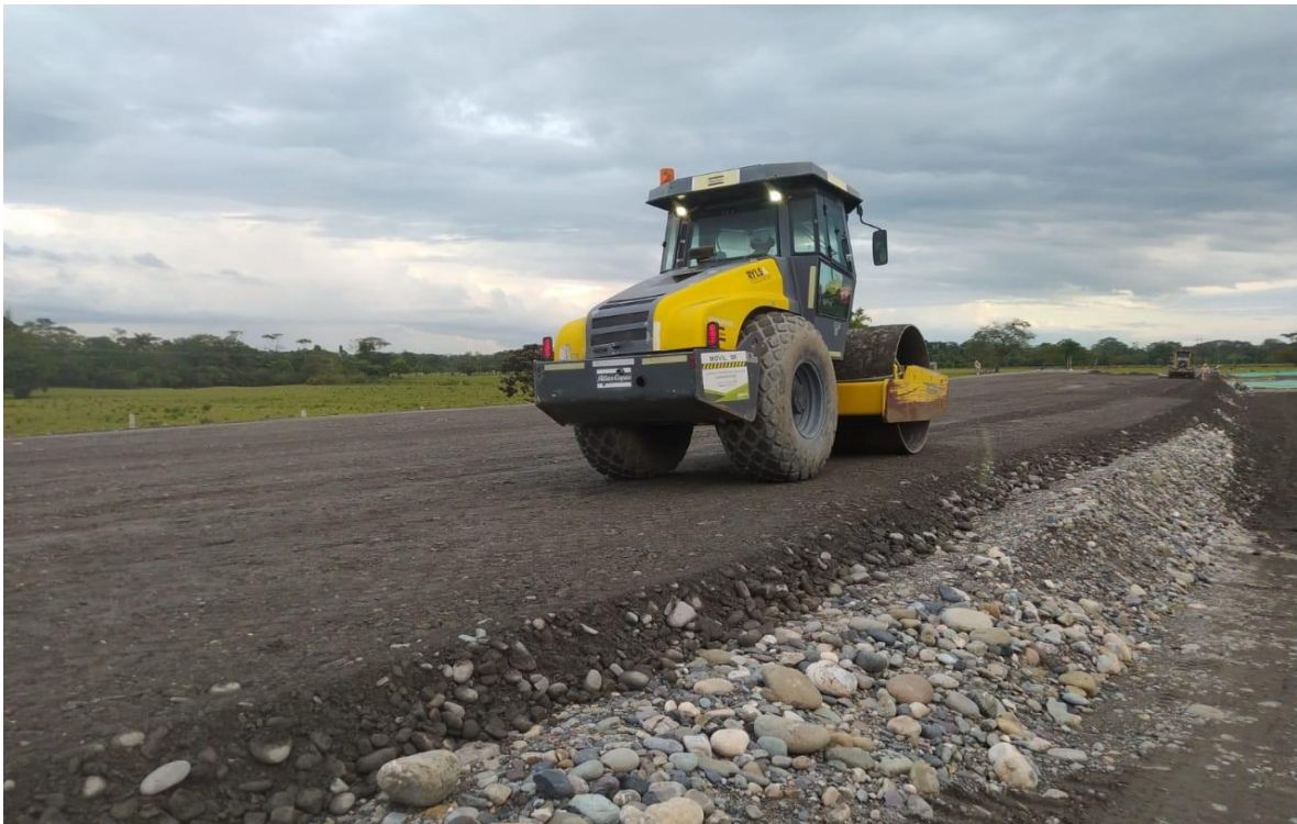
Conformación corona de terraplén K19+840 Unidad Funcional 2.
