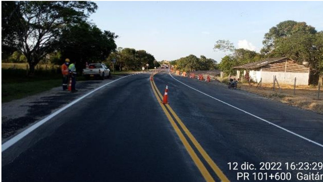
Pintado de la demarcación horizontal en empalmes de accesos al nuevo puente Yucao con la vía existente, ubicado en el PR101+0200 del corredor vial Puerto López – Puerto Gaitán.
