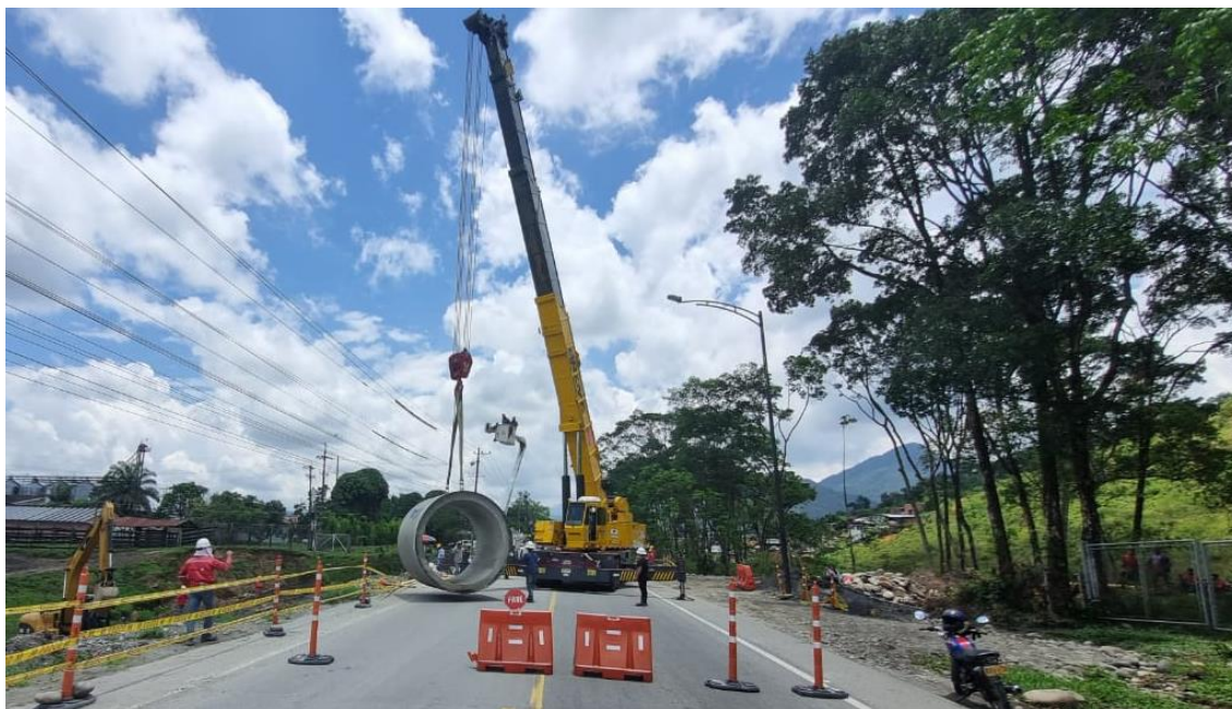
Atención de la emergencia en La Nohora, construcción de alcantarilla de 2,45 m de diámetro.
