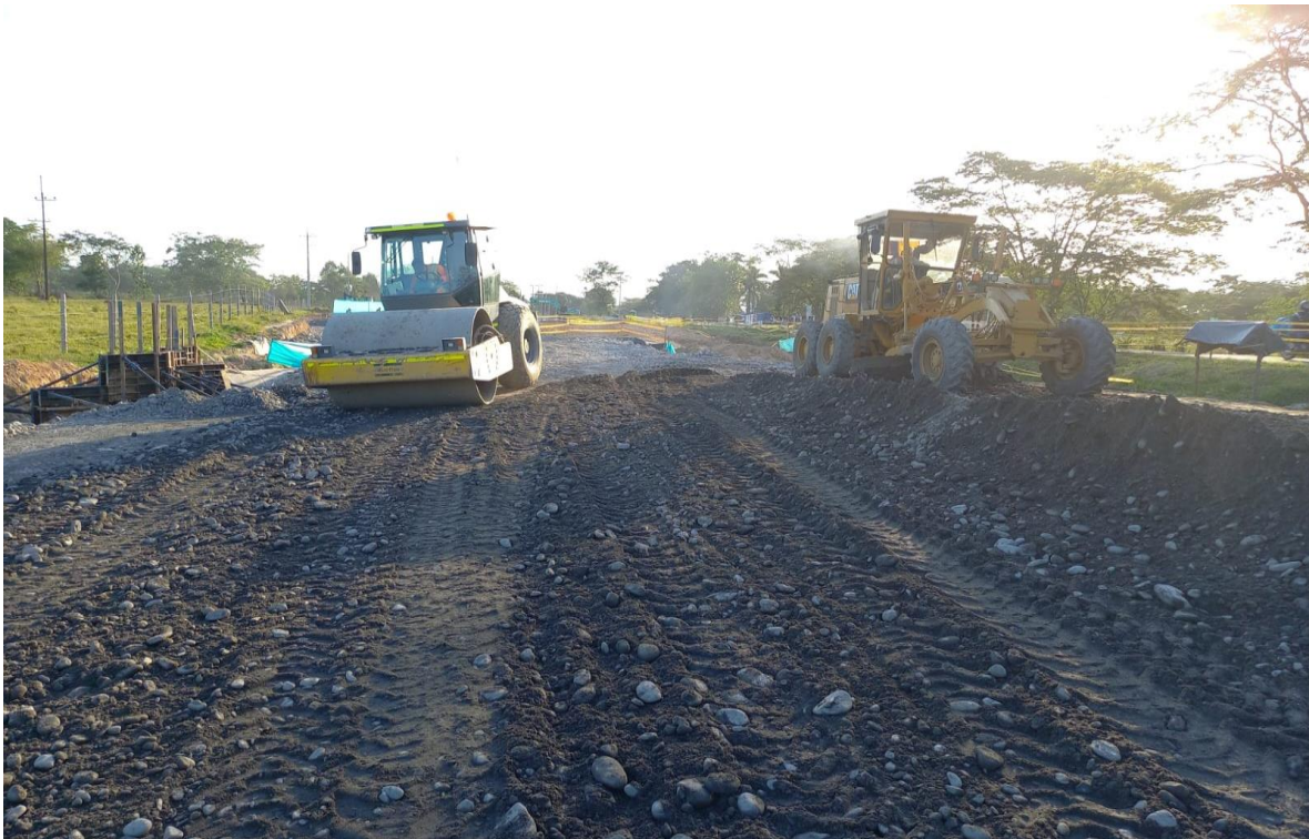
Conformación de terraplén K10+750, Unidad Funcional 3.
