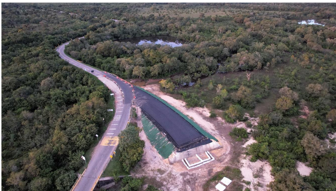
Pavimentación acceso del Puente Yucao, costado Puerto López, Unidad Funcional 7-8.
