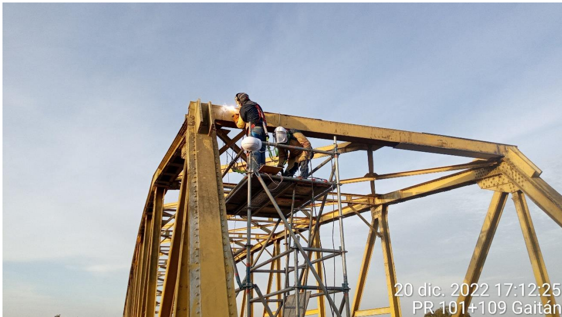
Reparación superestructura del puente Yucao.
