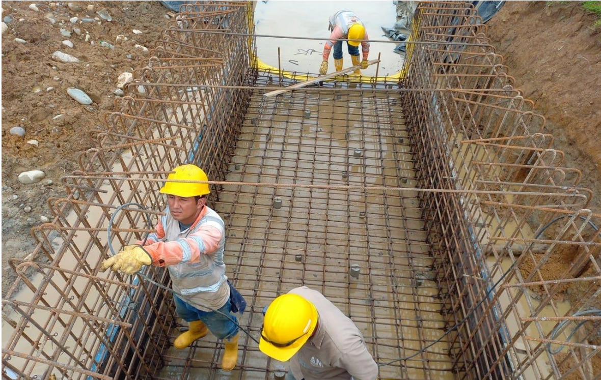
Armado de refuerzo box culvert K20+065, Unidad Funcional 2.
