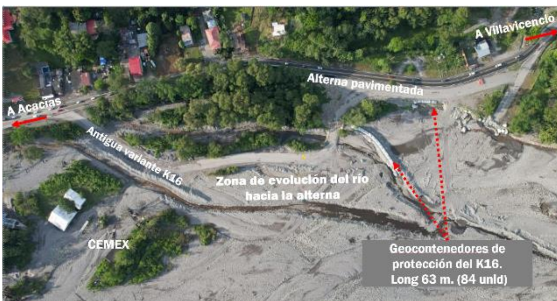
Paso alternativo pavimentado y habilitado al tráfico.
