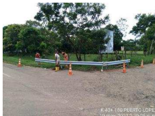
K40+180 Villavicencio – Puerto López: Instalación de defensas metálicas para protección de cuerpos profundos de agua
