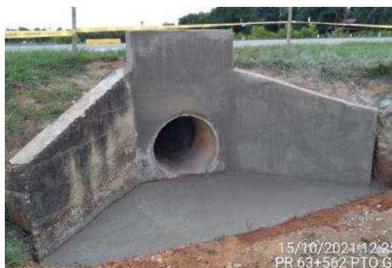
PR63+0562 Puerto López – Puerto Gaitán, reconstrucción muro y aleta de alcantarilla destruida por impacto de vehículo.
