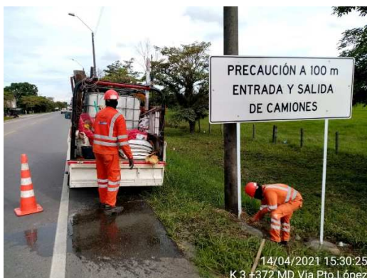
K3+372 Villavicencio – Puerto López: Instalación de señales informativas para advertir situaciones que requieran la atención del conductor.
