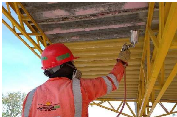
K46+890 Villavicencio – Granada Reparación de cubierta
