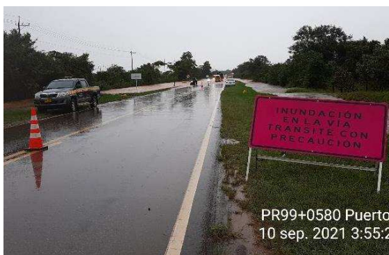
PR99+0500 Puerto López – Puerto Gaitán, señalización del área inundada y apoyo en el control del tráfico.
