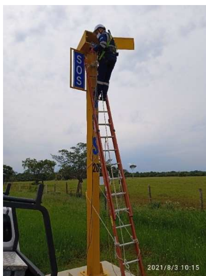
Mantenimiento poste SOS No. 20 Villavicencio – Puerto López
