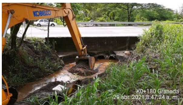
K0+180 variante Guayuriba / Villavicencio - Granada, limpieza mecánica canal de descole de alcantarilla.
