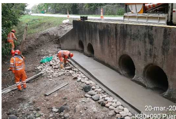
K30+090 Villavicencio - Puerto López, reparación del solado.
