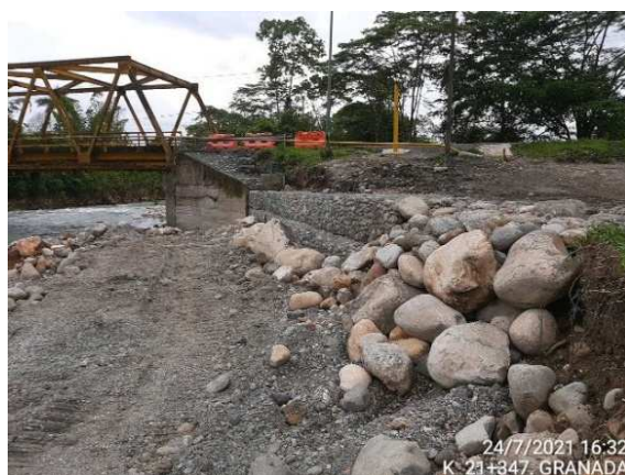
K21+347 Villavicencio – Granada , construcción de muro en gavión para control de socavación.
