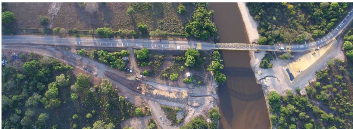
Panorámica aérea de los trabajos en los dos accesos al puente nuevo. Izq. Puerto Gaitán. Der. Puerto López.
