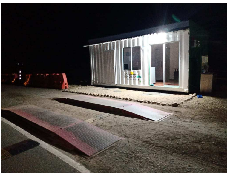
Báscula pesa – ejes (Yucao), Puerto López – Puerto Gaitán instalación de contenedor tipo oficina
