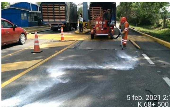
K68+500 Villavicencio - Granada: sello de juntas y fisuras en el peaje Iracá.
