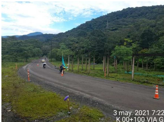
Variante Guayuriba / Villavicencio – Granada, habilitación de vía alterna para garantizar continuidad del servicio durante la inundación de variante del K16.
