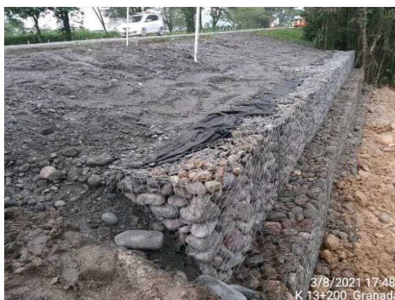
K13+200 Villavicencio – Granada , construcción de muro en gavión para control de estabilidad.
