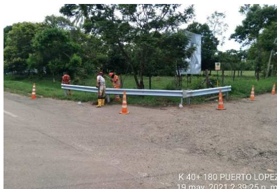
K40+180 Villavicencio – Puerto López, instalación de defensas para protección de cuerpos profundos de agua.
