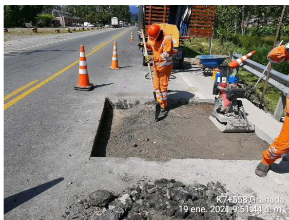
K7+558 Villavicencio – Granada, reparación del pavimento por socavación.
