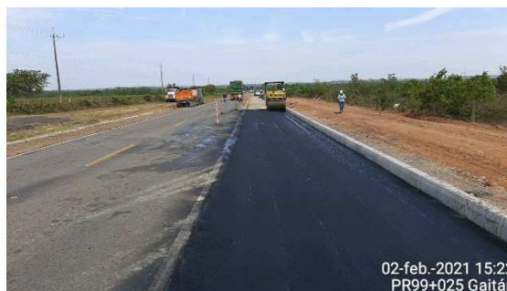
PR98+0798 al PR98+0966 Puerto López – Puerto Gaitán, construcción de los carriles de acceso y salida de la báscula Yucao.
