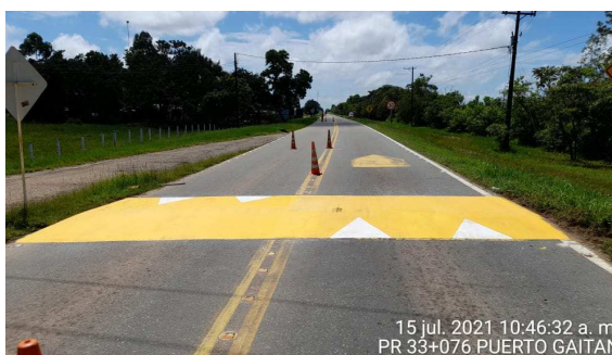
PR33+076 Puerto López – Puerto Gaitán, repintado de resalto y marcas viales en el sector de “Aquí es pues”.
