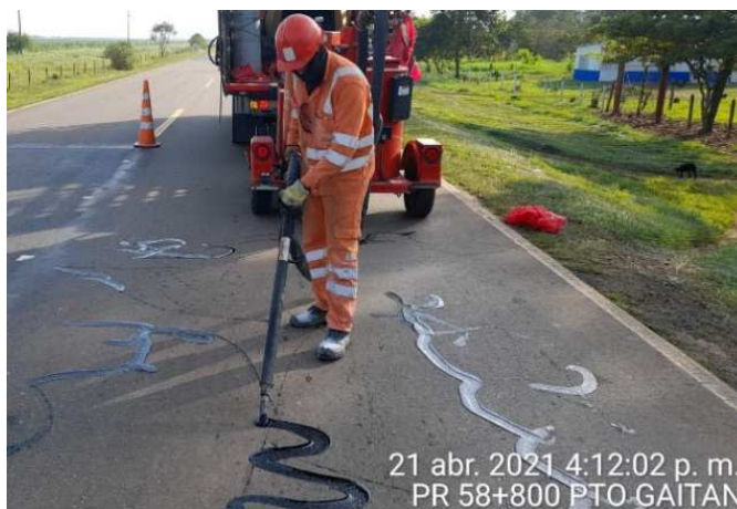
PR58+0800 Puerto López – Puerto Gaitán; sello de fisuras en pavimento flexible; la actividad la ejecuta con personal capacitado y equipos del Concesionario.
