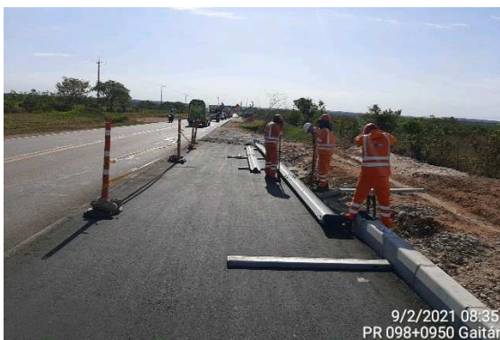
PR98+0950 Puerto López – Puerto Gaitán, instalación de defensas metálicas en los carriles de acceso a la báscula Yucao.
