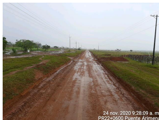
PR22+0950 Puerto Gaitán – Puente Arimena las actividades realizadas son escarificado y compactación de la rasante, adición y compactación de crudo de río, y conformación o limpieza de canales para mejorar la hidráulica del sector.
