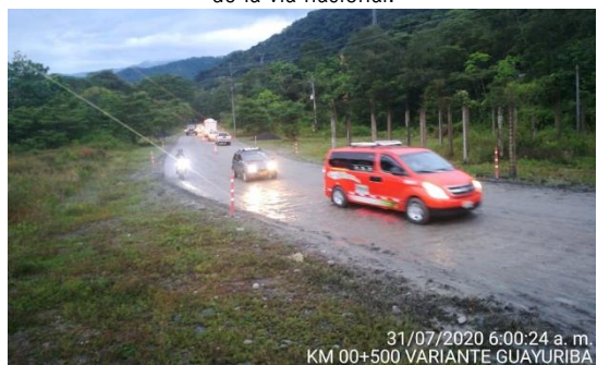
Variante Guayuriba / Villavicencio – Granada, se habilitó el paso por la vía alterna para mantener continuidad en la operación de la vía.
