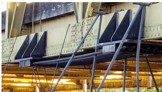
Actividades de reparación de la viga mediante la instalación de barras de acero de alta resistencia.
