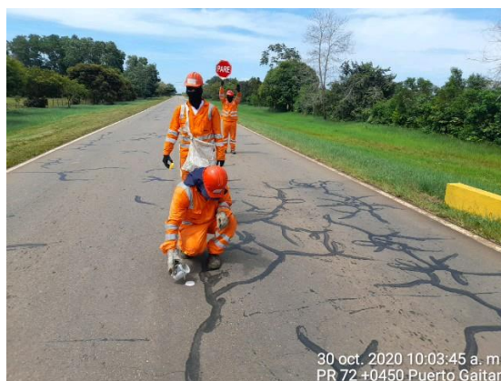
PR72+0450 Puerto López – Puerto Gaitán, reposición de tachas en borde de calzada.
