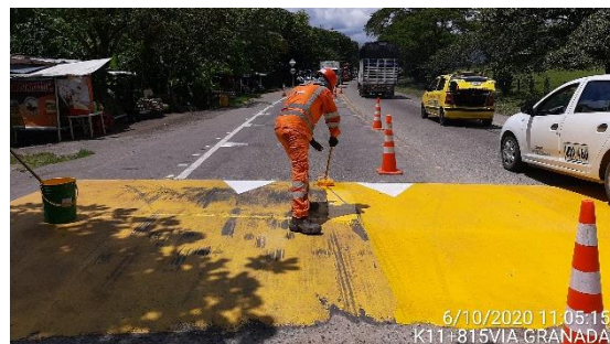
K11+815 Villavicencio – Granada, repintado de resaltos y marcas viales en el sector de Las Mercedes.
