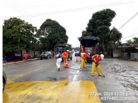
K37+400 Villavicencio – Granada, limpieza de la vía una vez se superó la emergencia.
