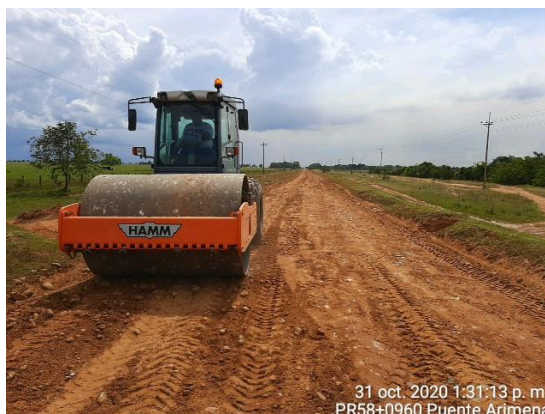
PR51+0000 al PR68+0300 Puerto Gaitán – Puente Arimena con el fin de mejorar la transitabilidad y optimizar los recursos disponibles, se escarificó y recompactó el material existente.
