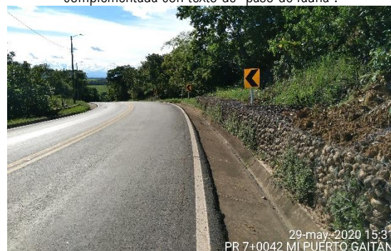
PR7+0042 Puerto López – Puerto Gaitán, instalación de delineadores de corona SP-75 para mejorar la seguridad vial.
