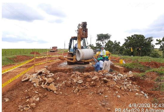
PR45+0293 Puerto Gaitán – Puente Arimena reparación de alcantarilla mediante la reposición de tubería fracturada.
