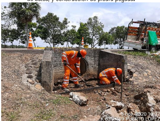
K63+199 Villavicencio - Puerto López , construcción de solado, realizado por personal propio.
