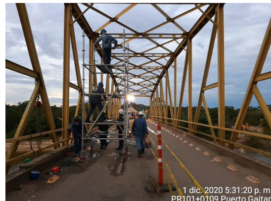
PR101+0109 Puerto López – Puerto Gaitán, labores de reparación del puente.
