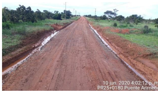
PR25+0180 Puerto Gaitán – Puente Arimena las actividades realizadas son escarificado y compactación de la rasante, adición y compactación de crudo de río, y conformación o limpieza de canales para mejorar la hidráulica del sector.
