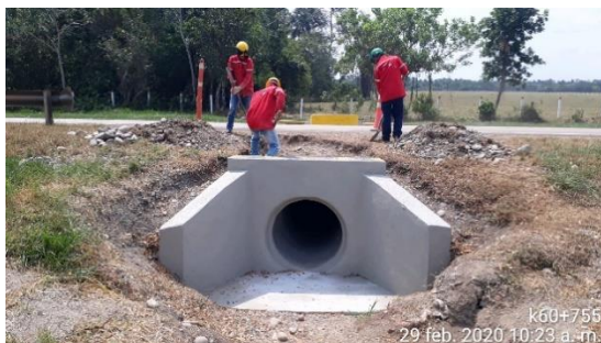
K60+755 Villavicencio - Puerto López , esta alcantarilla se intervino con recuperación de concreto de aletas y muro, recalce de batea, y construcción de piedra pegada.
