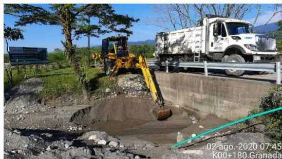
Variante Guayuriba / Villavicencio – Granada, Se limpiaron obras de drenaje y canales dentro de la variante.
