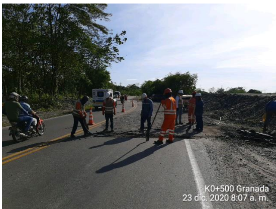
Variante Guayuriba / Villavicencio – Granada, reparación del pavimento en la zona más afectada por la inundación.
