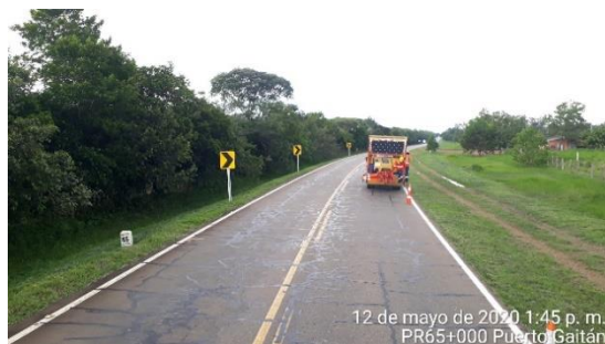
PR65 Puerto López – Puerto Gaitán, repintado de la demarcación horizontal del corredor vial.
