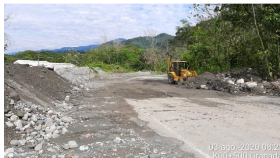
Variante Guayuriba / Villavicencio – Granada, Limpieza y retiro de materiales luego de que bajara el nivel de la inundación.
