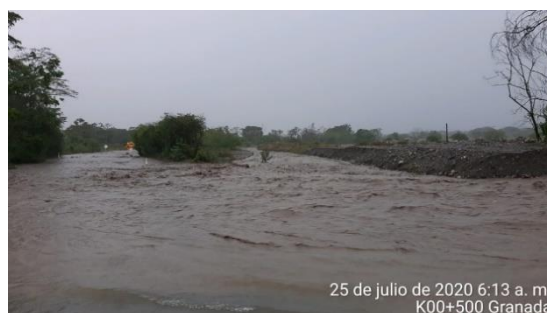
Variante Guayuriba / Villavicencio – Granada, inundación de la vía nacional y predio aledaño de Cemex.
