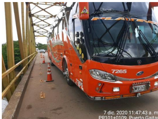
Habilitación de servicio sobre el puente el 7 de diciembre.
