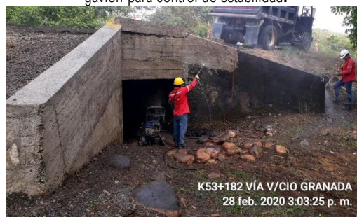
K53+182 Villavicencio – Granada , lavado de aletas para recuperación del concreto.
