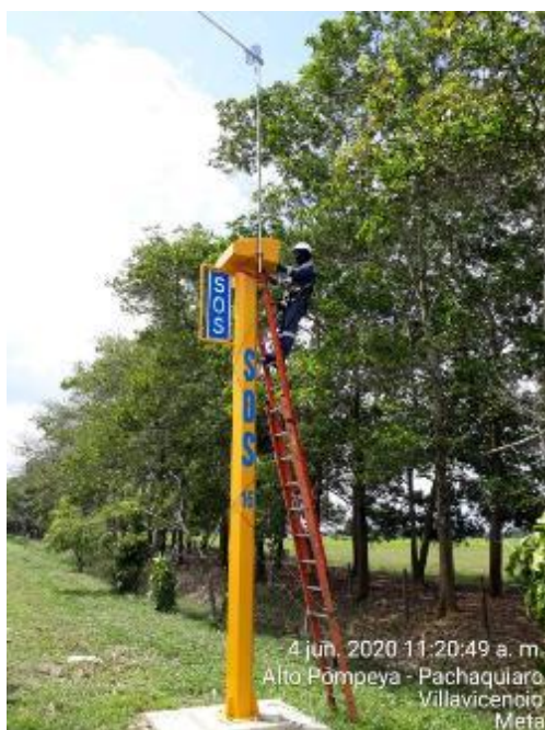
Mantenimiento poste SOS No. 16
