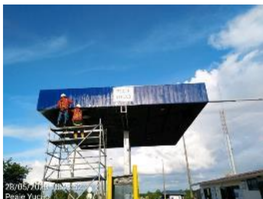
Mantenimiento de luminarias de cubierta Peaje Yuca PR99+0600
