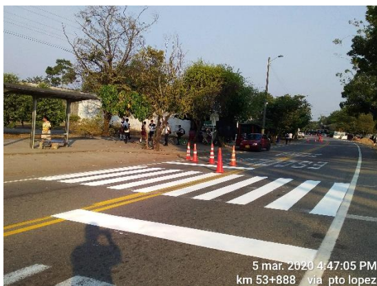
K53+888 Villavicencio – Puerto López, repintado de las marcas viales en la zona escolar de Pachaquiario.
