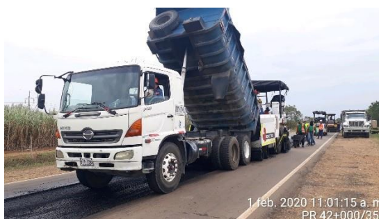
PR42+0000 Puerto López – Puerto Gaitán, instalación de mezcla asfáltica en caliente.
