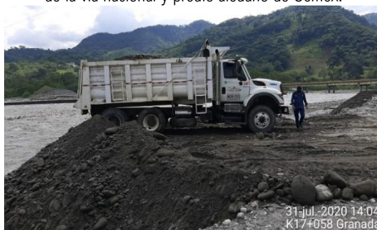
Variante Guayuriba / Villavicencio – Granada, el Concesionario apoyó a UGRD con 3 volquetas, 1 retroexcavadora y 40 mallas de gavión, para reforzar Jarillón.
