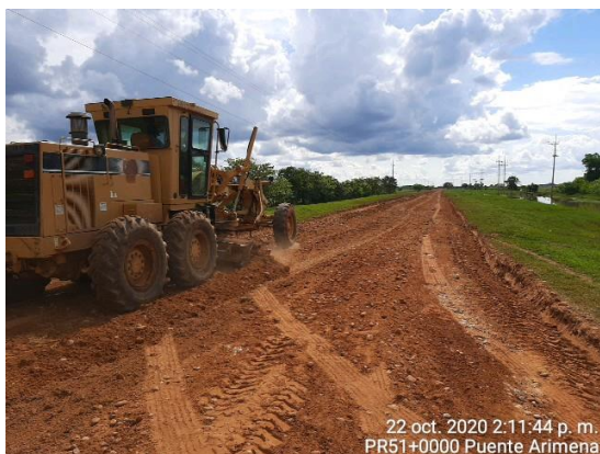
PR51+0000 al PR68+0300 Puerto Gaitán – Puente Arimena con el fin de mejorar la transitabilidad y optimizar los recursos disponibles, se escarificó y recompactó el material existente.
