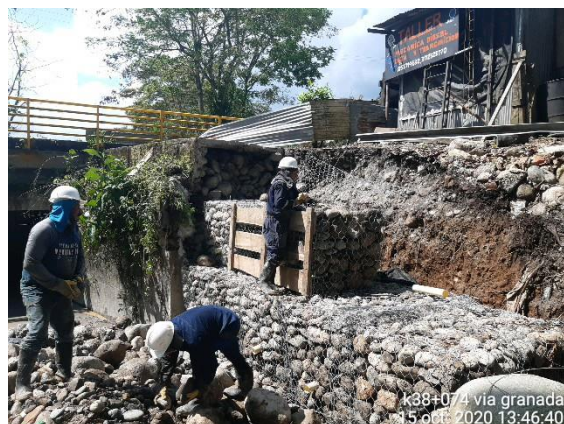
K38+100 Villavicencio – Granada , reconstrucción de muro afectado por la creciente del río Guamal.
