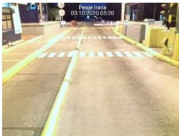
Limpieza general en carriles Peaje Iracá Km 68+466
