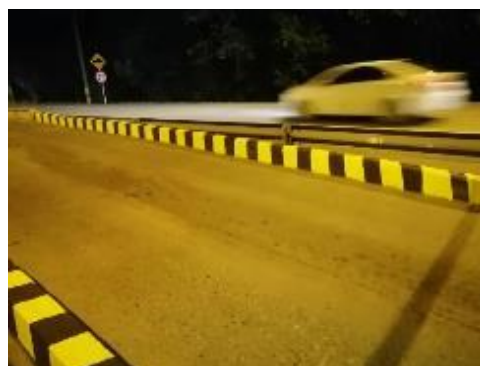
Aplicación de pintura en bordillos Peaje La Libertad Km 18+915
