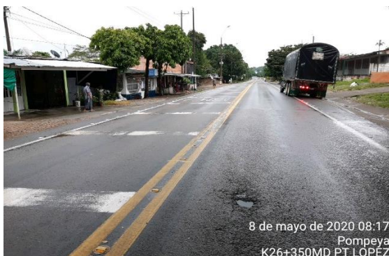
K26+350 paso por Pompeya – Villavicencio – Puerto López: desprendimiento localizado de rodadura; se realizó reparación puntual con mezcla asfáltica instantánea.
