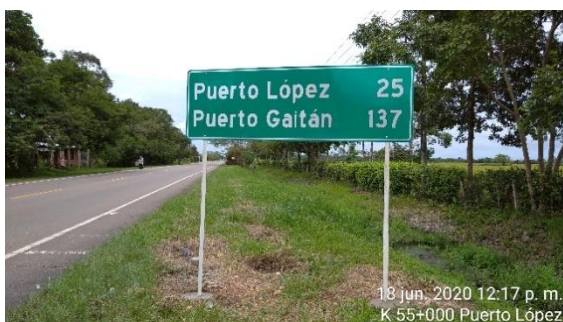
K55+000 Villavicencio – Puerto López, reposición de tablero por baja reflectividad.
