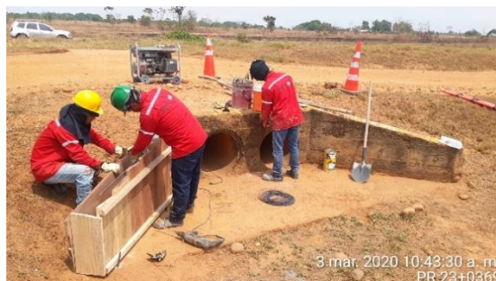
PR23+0369 Puerto Gaitán - Puente Arimena , reconstrucción de aleta.
