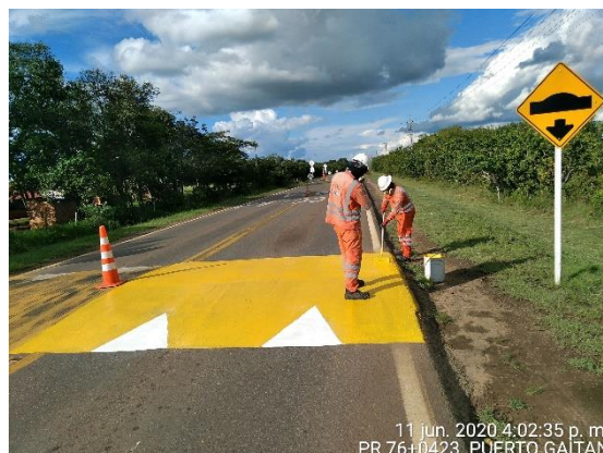
PR76+0423 Puerto López – Puerto Gaitán, repintado de resaltos en el sector de Pueblo Nuevo.
