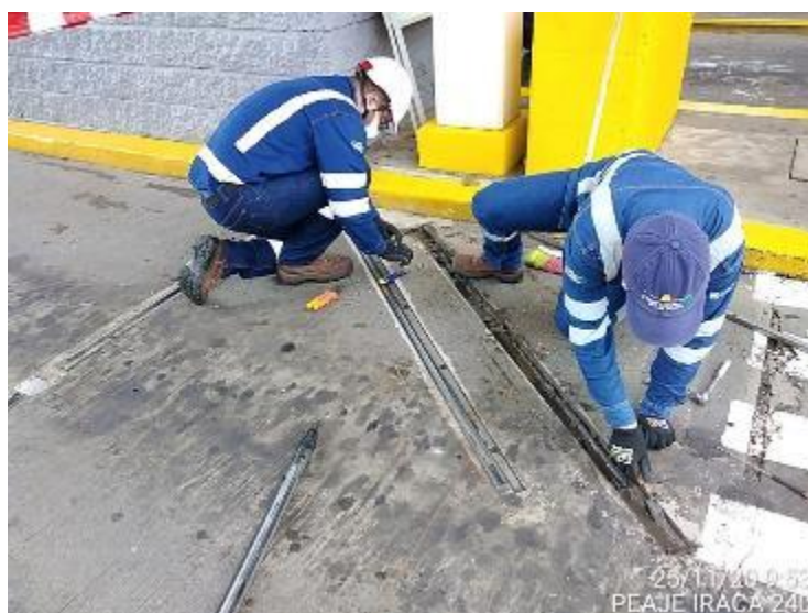
Mantenimiento de equipos de conteo vehicular - Peanas Peaje Iracá
