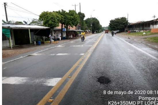
K26+350 paso por Pompeya – Villavicencio – Puerto López: desprendimiento localizado de rodadura; se realizó reparación puntual con mezcla asfáltica instantánea.
