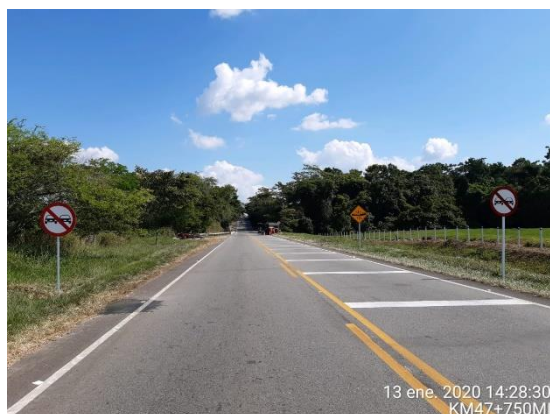
K47+750 Villavicencio – Granada, instalación de señal SR-26 complementaria a la señal existente.
