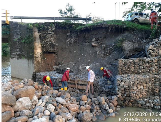
K31+646 Villavicencio – Granada , reconstrucción de muro afectado por la creciente del río Orotoy.
