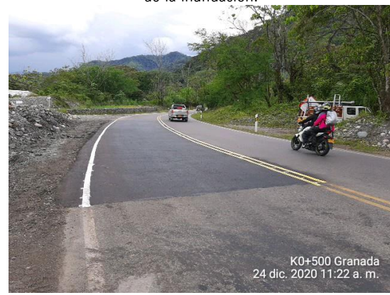
Variante Guayuriba / Villavicencio – Granada, terminación de trabajos de reparación y habilitación de la vía.
