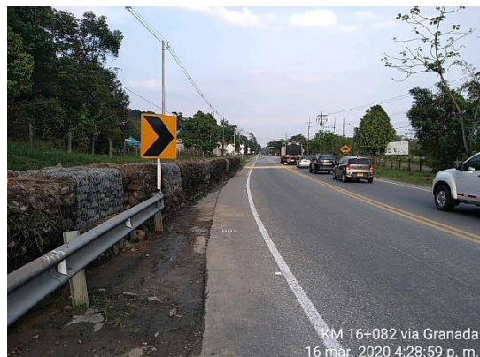
K0+000 variante Guayuriba / Villavicencio - Granada , reparación de muro de contención en gavión.
