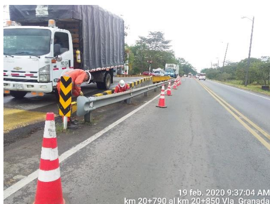
K20+790 Villavicencio – Granada, instalación de defensas para protección de la báscula Ocoa.
