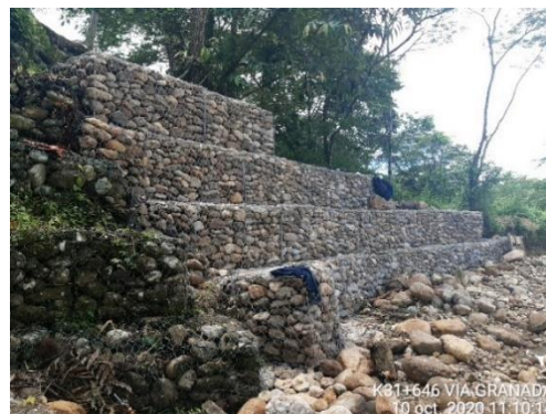
K31+646 Villavicencio – Granada , construcción de muro en gavión para control de estabilidad.
