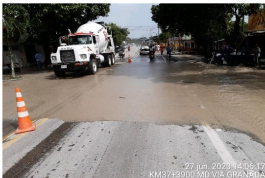
K37+370 Villavicencio – Granada, desbordamiento del río Guamal sobre la vía nacional.
