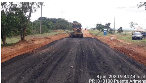
PR16+0600 al PR18+0200 Puerto Gaitán – Puente Arimena aprovechamiento del fresado estabilizado.
