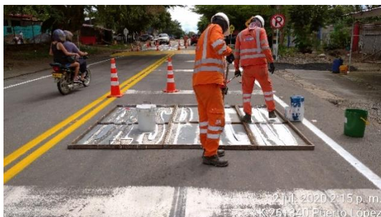
K26+340 Villavicencio – Puerto López, repintado de resalto y marcas viales en el sector de Pompeya.
