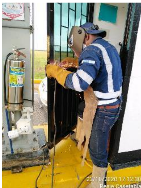
Mantenimiento de infraestructura Peaje Casetabla PR+16+140
