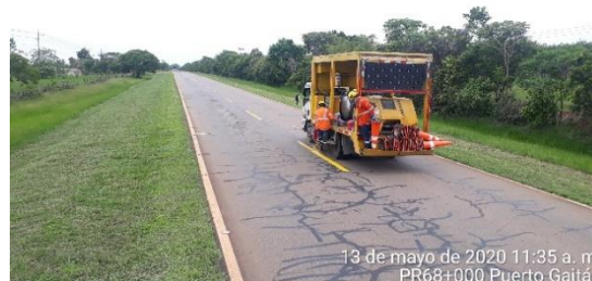
PR68 Puerto López – Puerto Gaitán, repintado de la demarcación horizontal del corredor vial.
