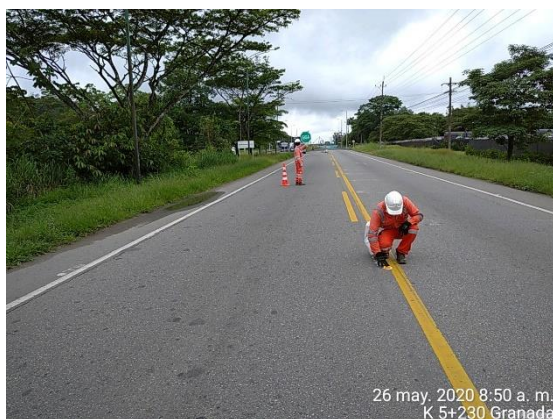
K5+230 Villavicencio – Granada, reposición de tachas en el eje de la calzada.
