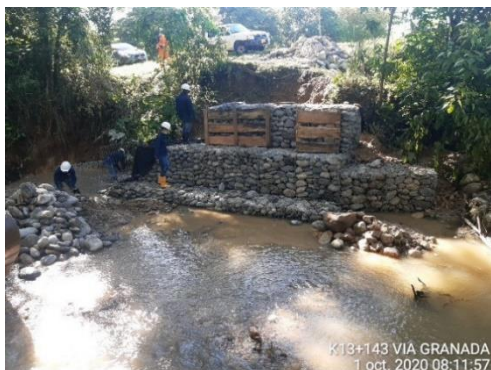
K13+143 Villavicencio – Granada , construcción de muro en gavión para control de estabilidad.
