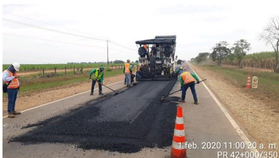
PR42+0000 Puerto López – Puerto Gaitán, instalación de mezcla asfáltica en caliente.
