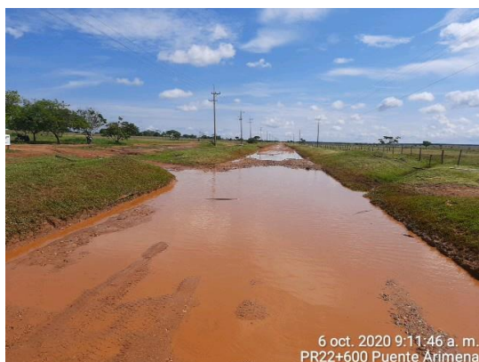
PR22+0600 Puerto Gaitán – Puente Arimena estado del carreteable antes de la intervención.
