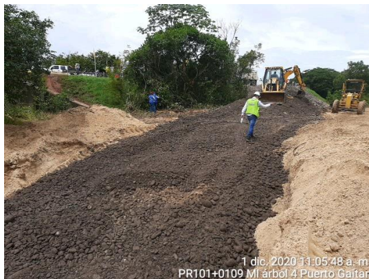
PR101+0109 Puerto López – Puerto Gaitán, adecuación de vía alterna para acceder al transbordador.
