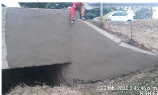
K38+100 Villavicencio – Granada , construcción de muro en gavión para control de estabilidad.
