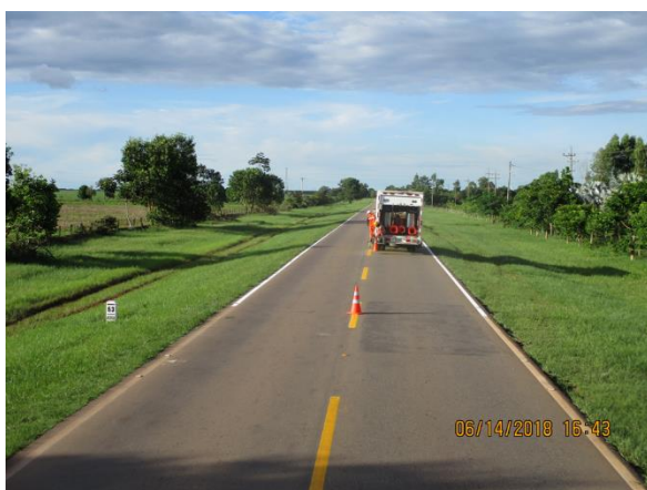
Demarcación PR63+0000 Puerto López – Puerto Gaitán.
