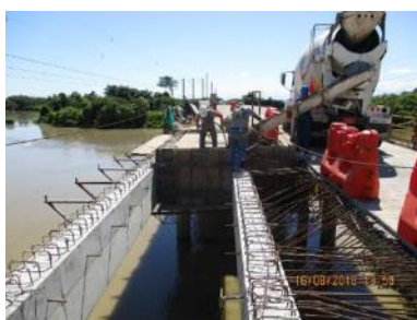
PR6+0500 Puerto López – Puerto Gaitán / puente Bajo Menegua Reparación Vano 7 Cambio 4 vigas y la placa: alistamiento y amarre de refuerzo e inicio de fundida de concreto del carril derecho del tablero del vano 7
