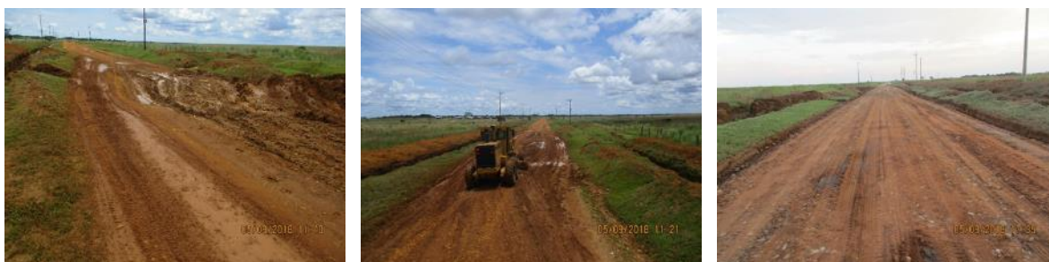
PR20+0900, extendida y compactación de material crudo de río, conformación de calzada y conformación de calanes.
