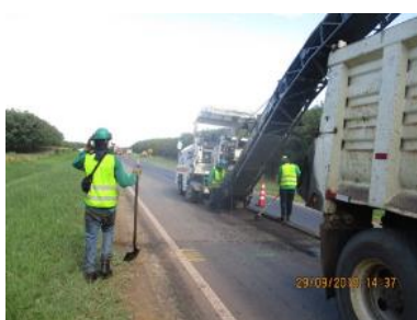
PR92+0891 Puerto López – Puerto Gaitán: Parcheo puntual con mezcla densa en caliente (MDC-19) en áreas con daño severo alta susceptibilidad de formación de bache.
