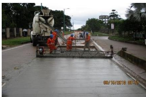
PR110+0480 – PR111+0883 Puerto López - Puerto Gaitán, reposición de 41 losas de pavimento rígido.
