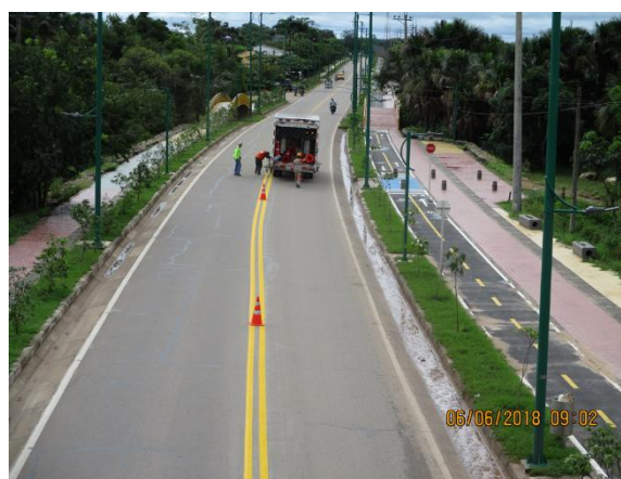
Demarcación PR108 al PR111 Paso Urbano Puerto Gaitán, Puerto López – Puerto Gaitán.
