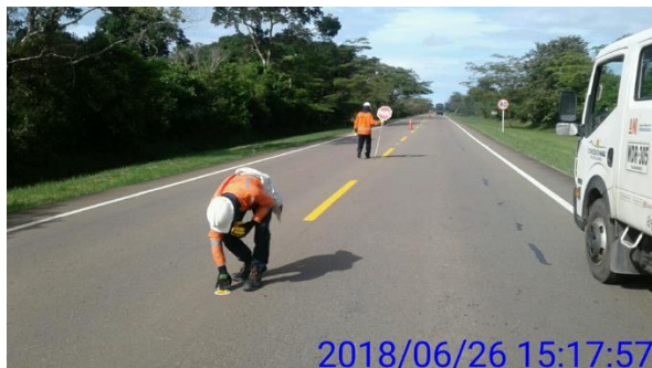
Reposición puntual de tachas entre el K2 y K26 de la vía Villavicencio – Puerto López
