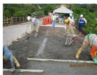
PR6+0500 Puerto López – Puerto Gaitán / puente Bajo Menegua Reparación Vano 7 Cambio 4 vigas y la placa: alistamiento y amarre de refuerzo e inicio de fundida de concreto del carril derecho del tablero del vano 7
