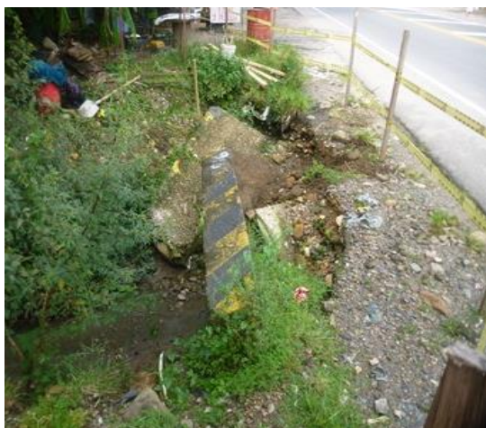
K7+850 Villavicencio - Granada: reconstrucción de muro y aletas de en la alcantarilla, el cual fue destruido por impacto de vehículo.
