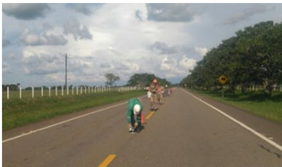
K48+000 al K53+600 Villavicencio – Puerto López, instalación de tachas para mejorar las condiciones de seguridad vial.
