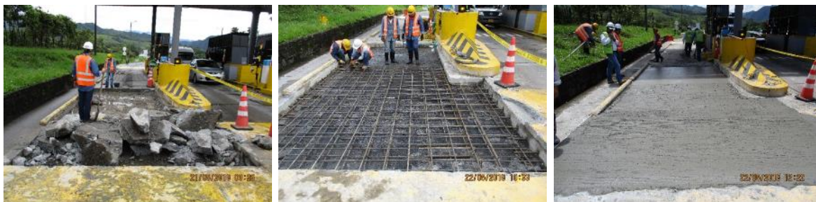
K20+700 Villavicencio – Granada. Peaje Ocoa: reposición de dos (2) losas de concreto y sello de 88 metros lineales de fisura en las losas adyacentes.
