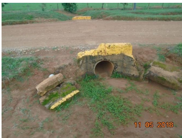
PR42+0650 Puerto Gaitán – Puente Arimena reconstrucción de muro cabecal y aletas de la alcantarilla.
