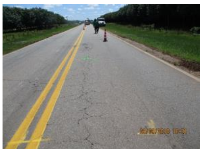
PR92+0891 Puerto López – Puerto Gaitán: Parcheo puntual con mezcla densa en caliente (MDC-19) en áreas con daño severo alta susceptibilidad de formación de bache.
