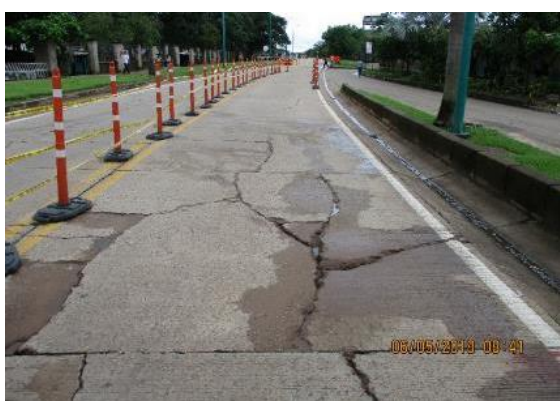
PR110+0480 – PR111+0883 Puerto López - Puerto Gaitán, reposición de 41 losas de pavimento rígido.
