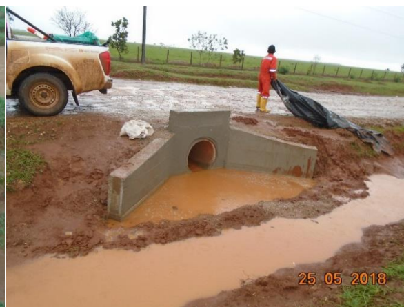
PR42+0650 Puerto Gaitán – Puente Arimena reconstrucción de muro cabecal y aletas de la alcantarilla.
