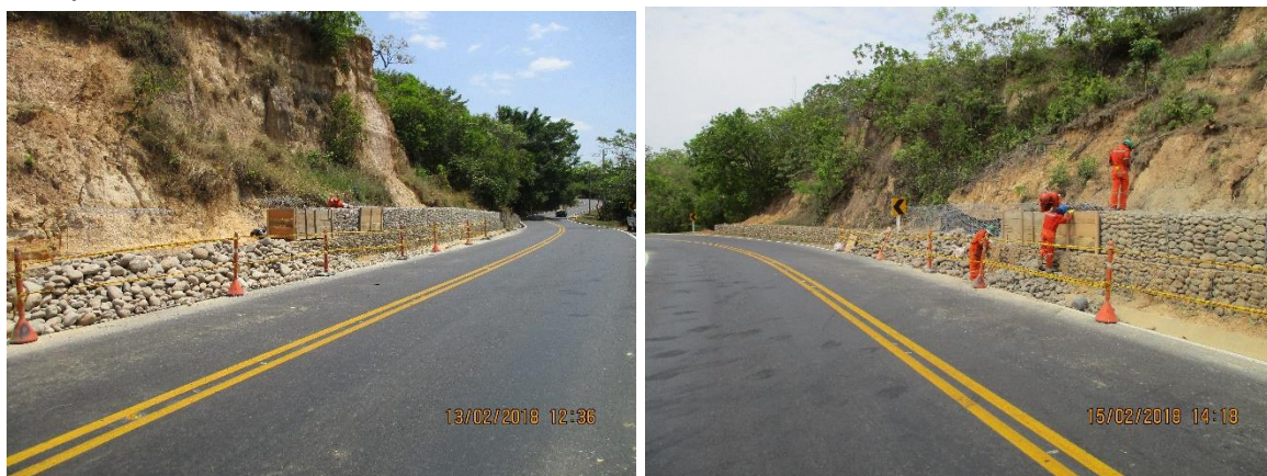
PR7+0000 Puerto López – Puerto Gaitán: construcción de muros en gavión.
