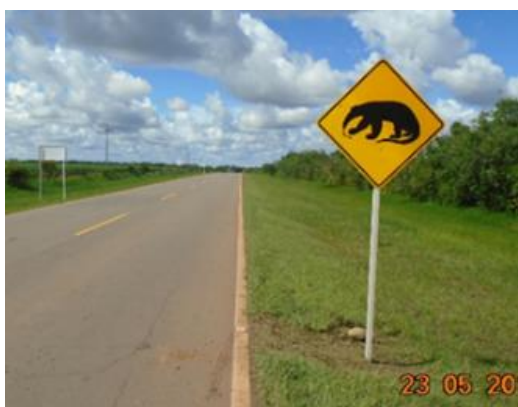
PR54+620 Puerto López – Puerto Gaitán, reposición de tablero que había sido hurtado.
