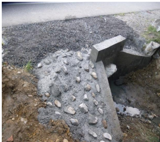
K7+850 Villavicencio - Granada: reconstrucción de muro y aletas de en la alcantarilla, el cual fue destruido por impacto de vehículo.
