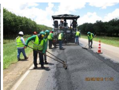
PR92+0891 Puerto López – Puerto Gaitán: Parcheo puntual con mezcla densa en caliente (MDC-19) en áreas con daño severo alta susceptibilidad de formación de bache.
