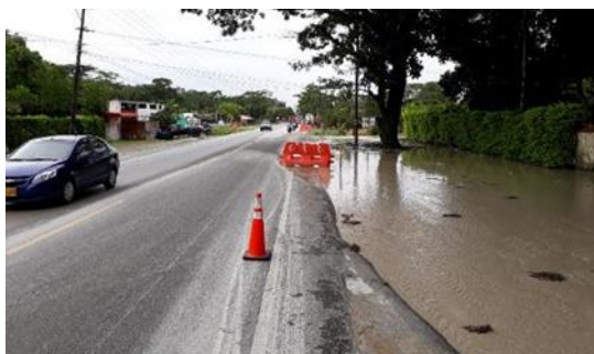
K36+450 (cruce Las Mulas), inundación de calzada.
