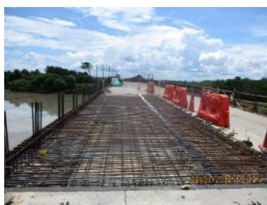
PR6+0500 Puerto López – Puerto Gaitán / puente Bajo Menegua Reparación Vano 7 Cambio 4 vigas y la placa: alistamiento y amarre de refuerzo e inicio de fundida de concreto del carril derecho del tablero del vano 7
