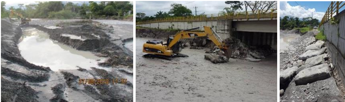
K39+446 Caño Negritos: actividades de canalización del río y protección del material del aproche sur del puente.
