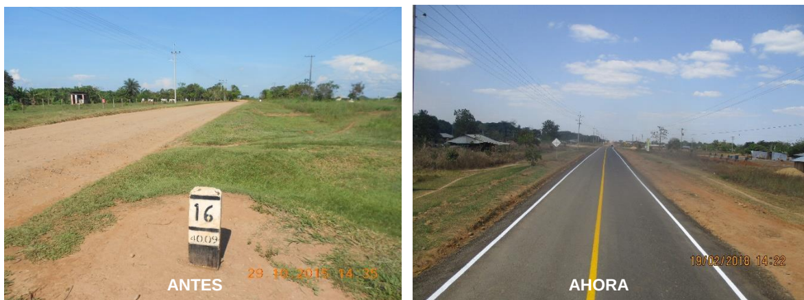
PR16+0000 al PR16+0600- Puerto Gaitán – Puente Arimena: trabajos de aprovechamiento del fresado estabilizado con emulsión.
