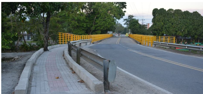
K45+380 y construcción espacio público puente peatonal
