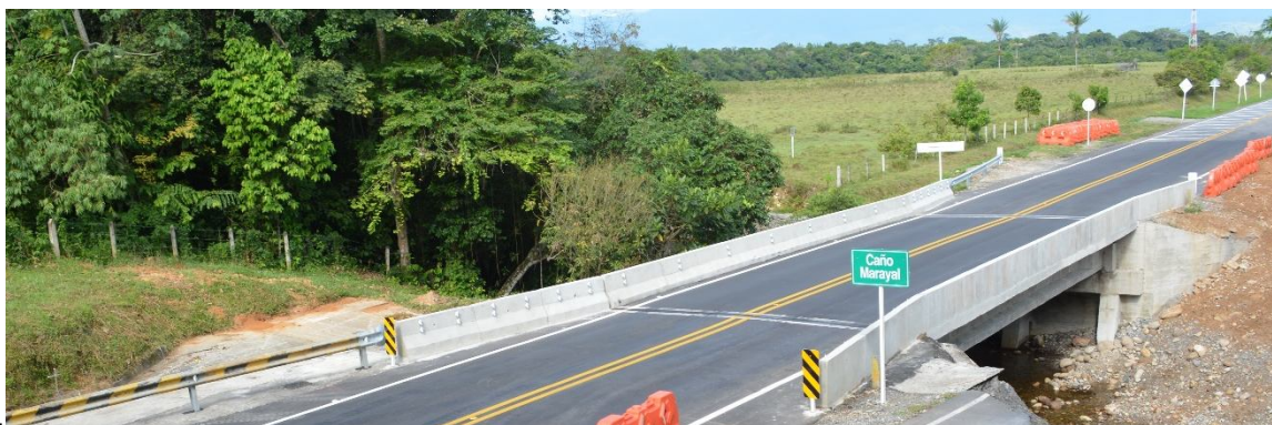
K47+871 Vía Villavicencio – Granada: Puente Marayal Reconstruido Superestructura
