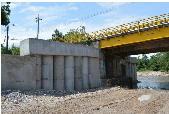
K45+380 Pilotaje Protección estribo derecho Aguas Abajo
