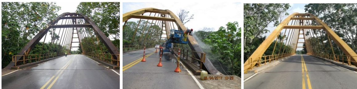
Lavado general del puente La Balsa en el K68+850 Villavicencio – Puerto López.
