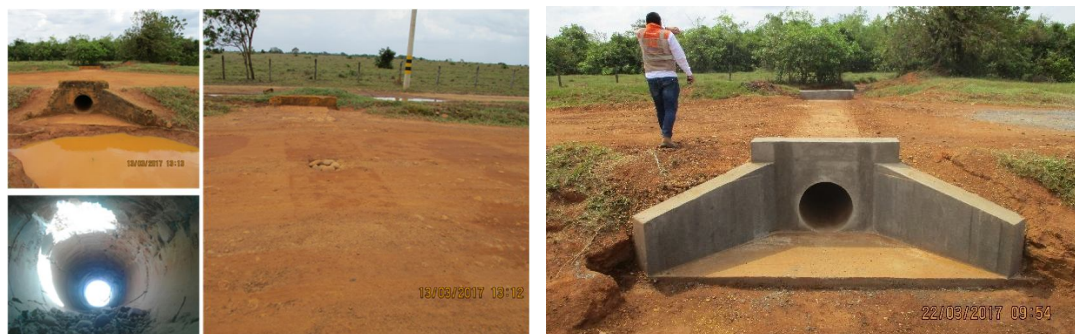
PR40+0540 Puerto Gaitán – Puente Arimena: restitución de alcantarilla por daños en cabezales y ducto.
