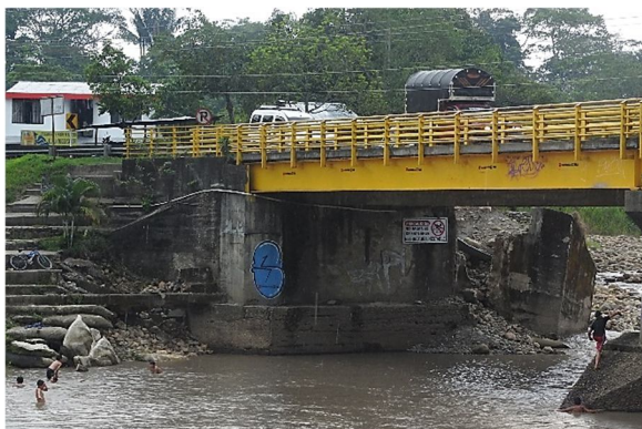
K45+380 Pilotaje Protección estribo derecho Aguas Abajo
