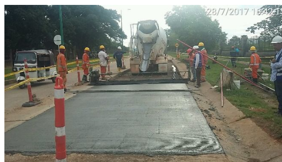
PR109 Vía Puerto. López – Puerto. Gaitán: Reposición Losas Puerto Gaitán
