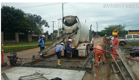
PR109 Vía Puerto. López – Puerto. Gaitán: Reposición Losas Puerto Gaitán
