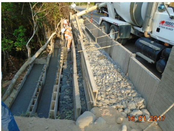
PR8+0000: complemento de las obras para estabilización del talud que incluyeron: revestimiento de gaviones en concreto y construcción de cuneta.
