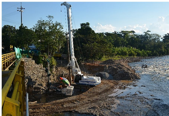
K45+380 Vía Villavicencio – Granada: Protección estribo derecho Puente Humadea Aguas Arriba
