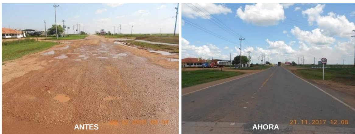
PR6+500 Puerto Gaitán – Puente Arimena: trabajos de aprovechamiento del fresado estabilizado con emulsión.
