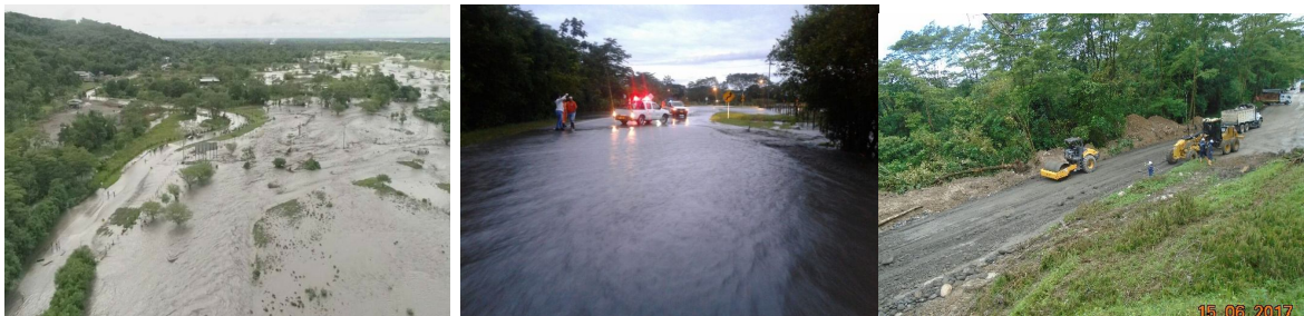
Inundación variante del K16 en la vía a Granada.
