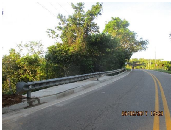
PR8+0000: complemento de las obras para estabilización del talud que incluyeron: revestimiento de gaviones en concreto y construcción de cuneta.
