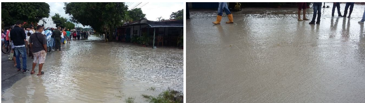
K37+365 Villavicencio - Granada: sitio donde la creciente del río Guamal rebosó la rasante de la vía concesionada.
