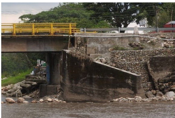
K45+380 Vía Villavicencio – Granada: Protección estribo derecho Puente Humadea Aguas Arriba
