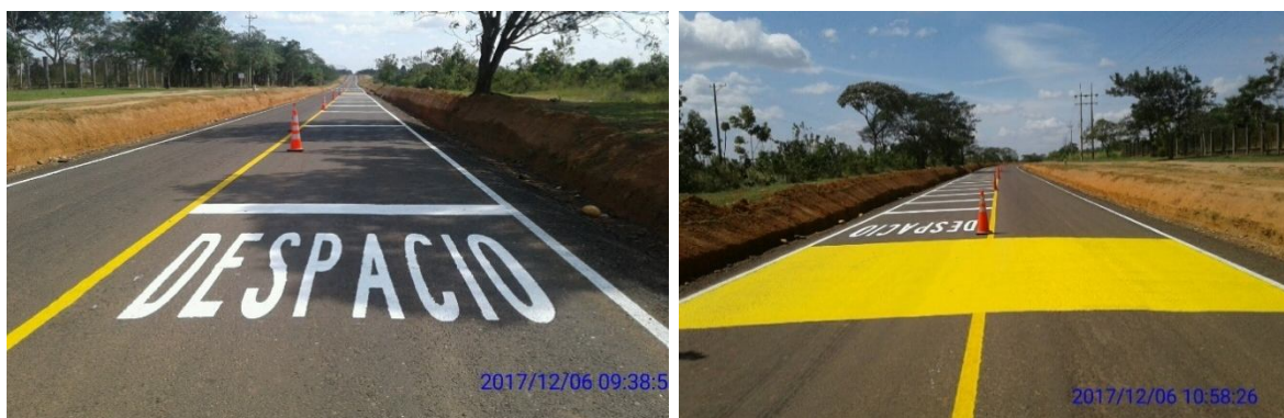
PR15 Puerto Gaitán – Puente Arimena: Sector estabilizado con fresado y emulsión. Pintado de marcas viales en la Institución Educativa Kuwei
