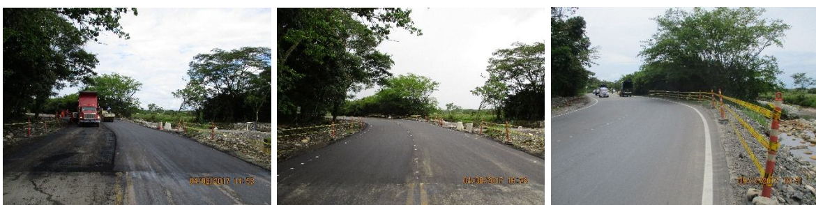
Reparación pavimento afectado por inundación variante del K16 en la vía a Granada.
