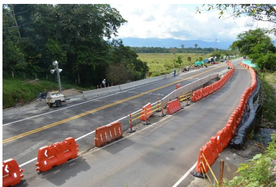
Fundida tablero y vía alterna provisional
