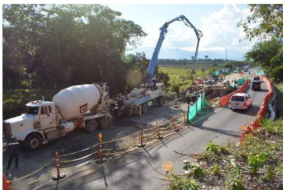
Fundida tablero y vía alterna provisional
