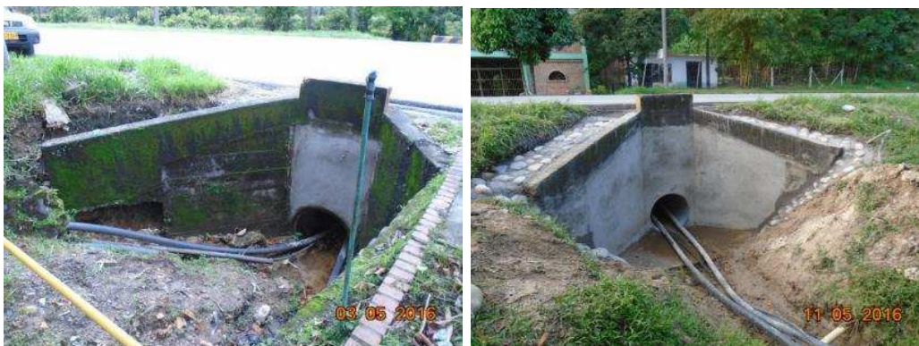
K15+567 V/cio. – Granada: Mantenimiento aletas y cuerpo de la alcantarilla y control de erosión con piedra pegada.
