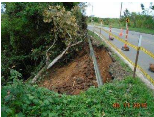
PR8+0040 vía a Puerto Gaitán. Inestabilidad talud margen izquierda de la vía.
