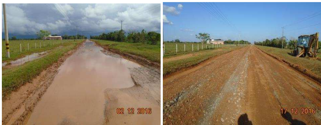
PR43+0500 Reparación mediante adición de material crudo de río.
