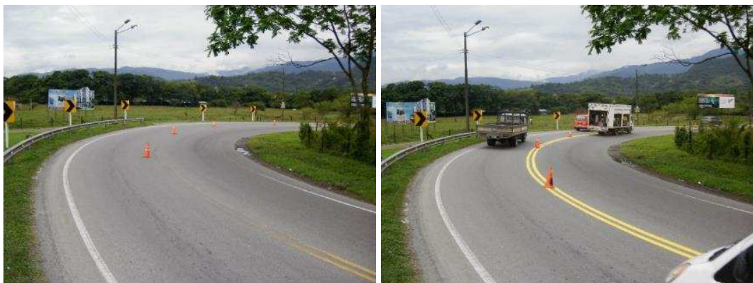
Demarcación horizontal vía Villavicencio – Granada.
