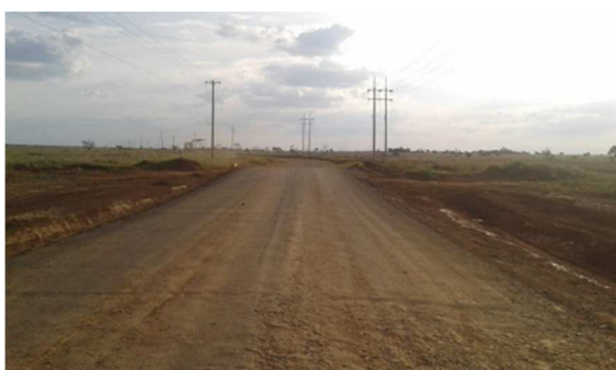
PR22 tramo prueba PROESTECH. Con recubrimiento Slurry
