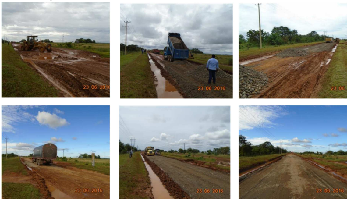
Trabajos de reparación del carreteable con adición de material crudo de río.
