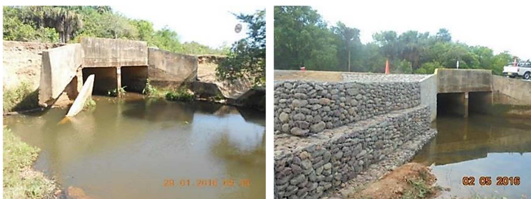
Reparación alcantarilla en cajón PR97+0913 vía a Gaitán.
