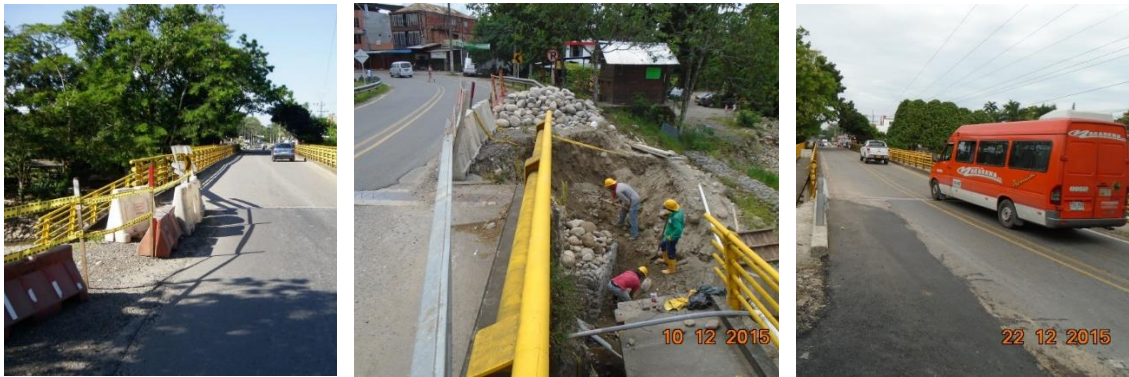
Puente Humadea, reparación de acceso.
