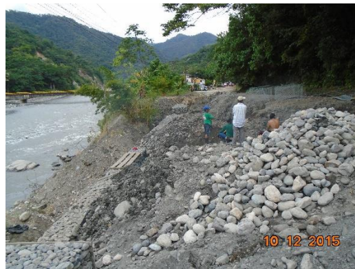
K17. INVIAS construye muro en gavión margen izquierda río Guayuriba, vía antigua.
