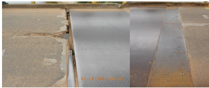
Puente Yucao. Antes y después Junta expansión costado Puerto López
