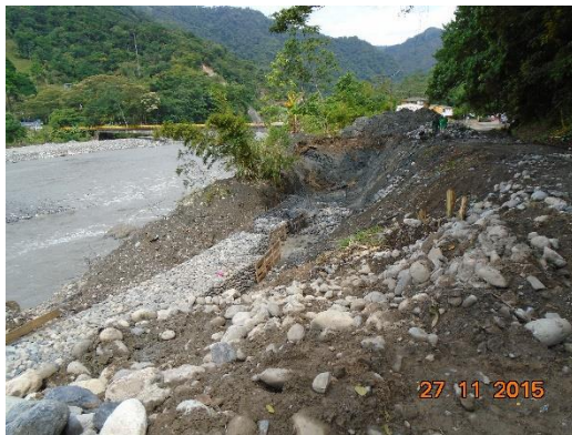
K17. INVIAS construye muro en gavión margen izquierda río Guayuriba, vía antigua.
